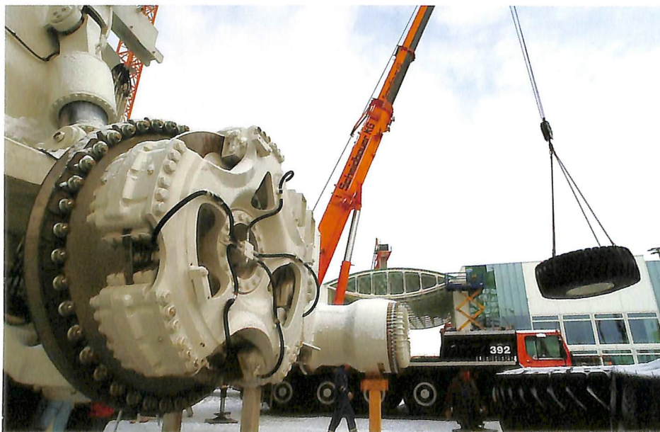
Montagem e desmontagem de Bauma: uma gigantesca obra de construção.
