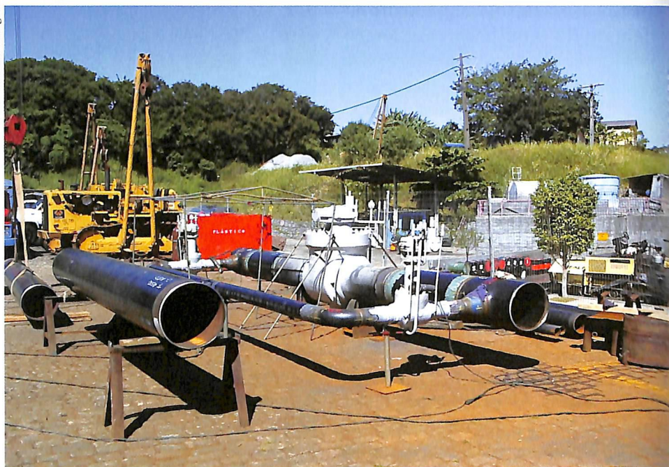
Montagem de dutos para obra da Comgás.
