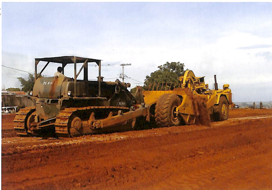
Obras rodoviárias: o novo foco do Batalhão de Araguari.
