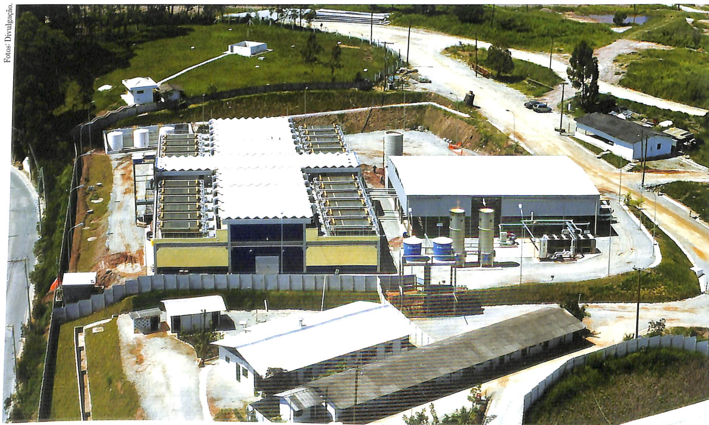
Planta irá captar 12 mil m 3 /hora de gás bioquímico emanado do lixo.
