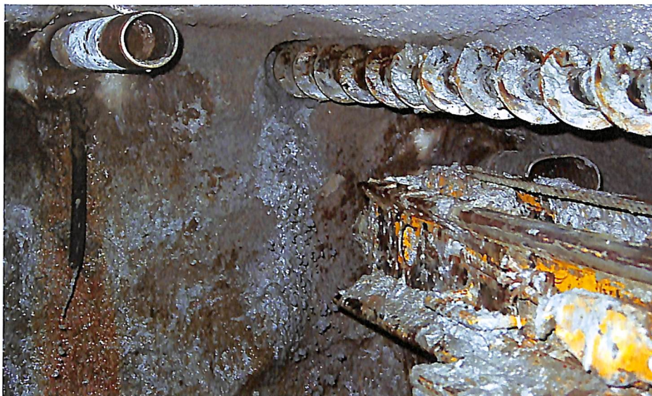
Detalhe da perfuração a seco mostra pó de pedra saindo do furo.
