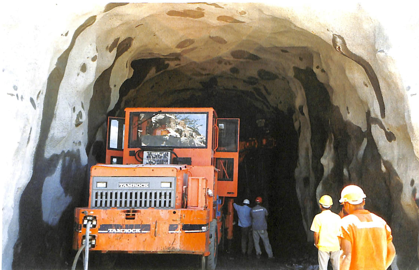
Jumbo Tamrock Maxi 206/120 no emboque do túnel de desvio.
