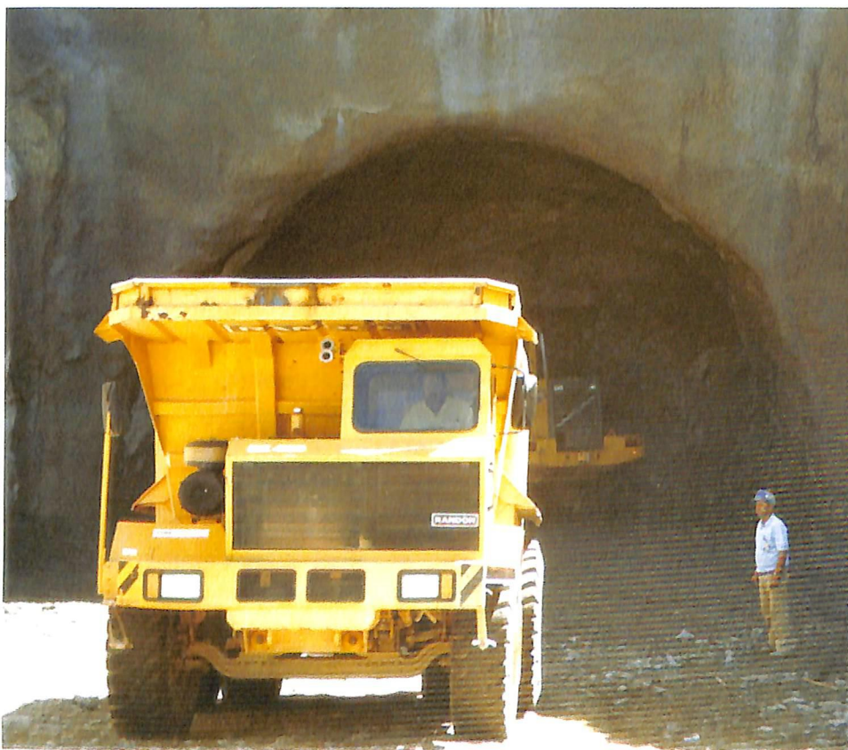
RK 430 com a carregadeira L120, opção para operação em espaços confinados.
