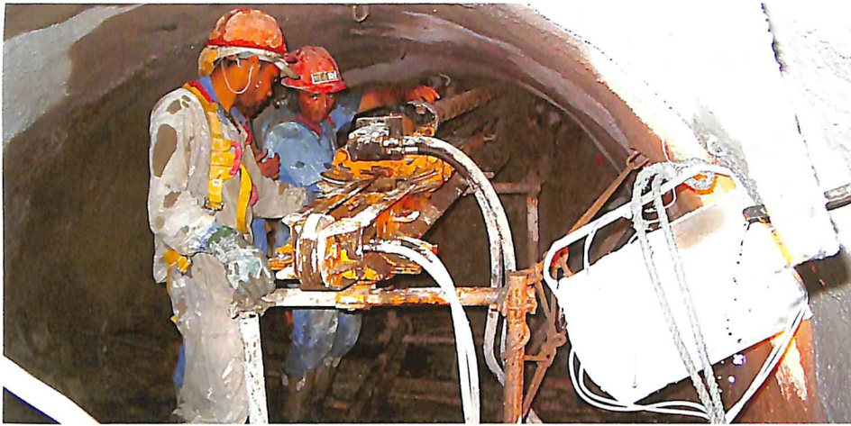
Execução de enfilagem na parte superior da abóbada do túnel.
