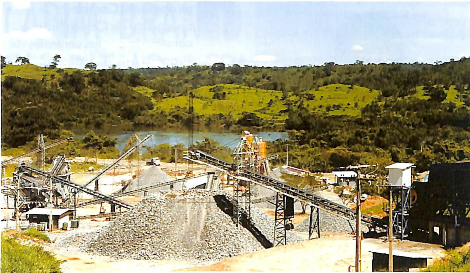
Instalação de Britagem em Capim I para 120t/h.
