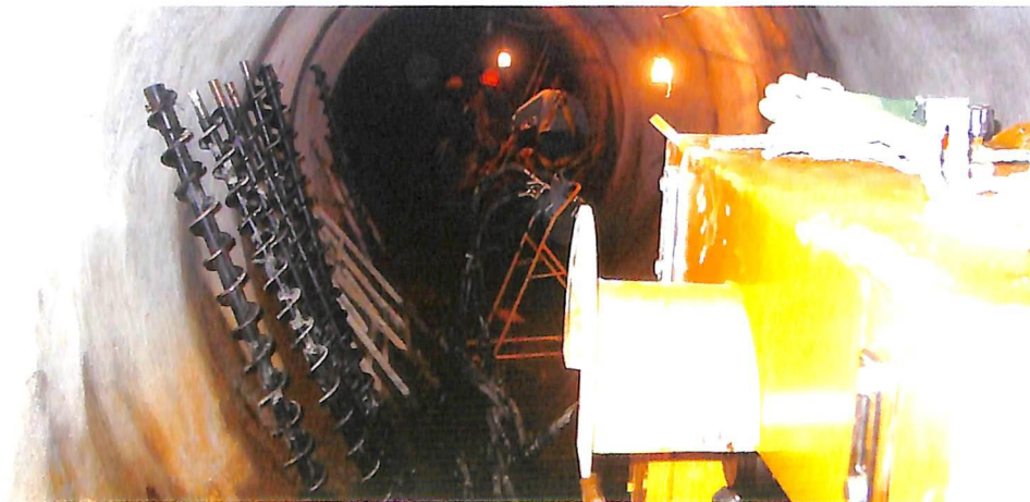
Diâmetro reduzido do túnel condicionou disposição sequencial de equipamentos.
