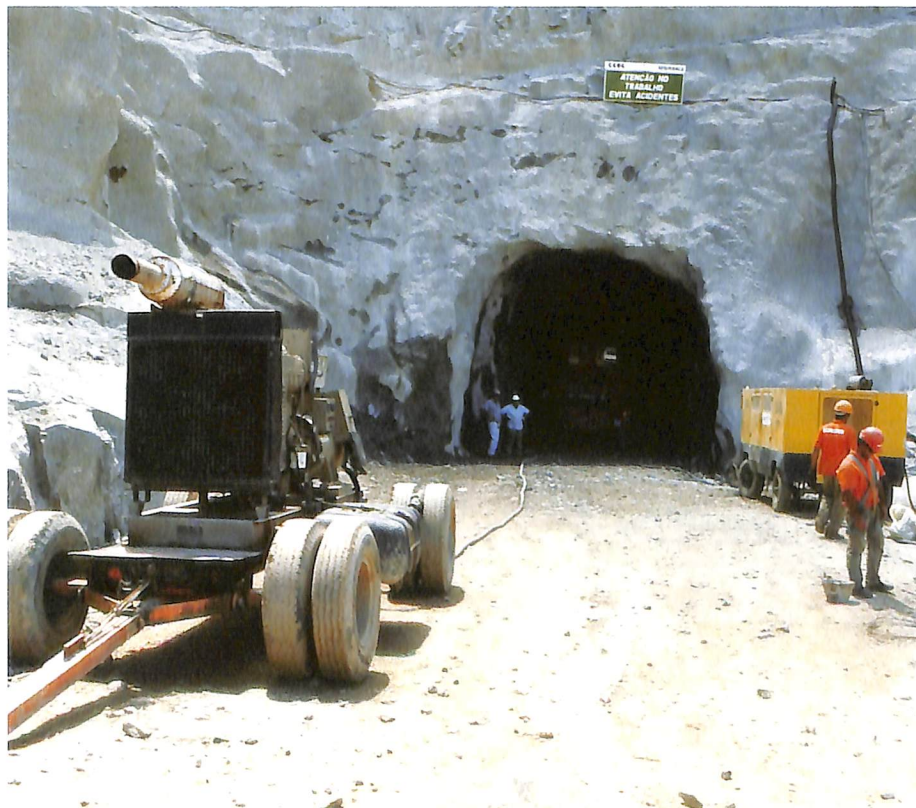
Execução para desvio do rio em julho.
