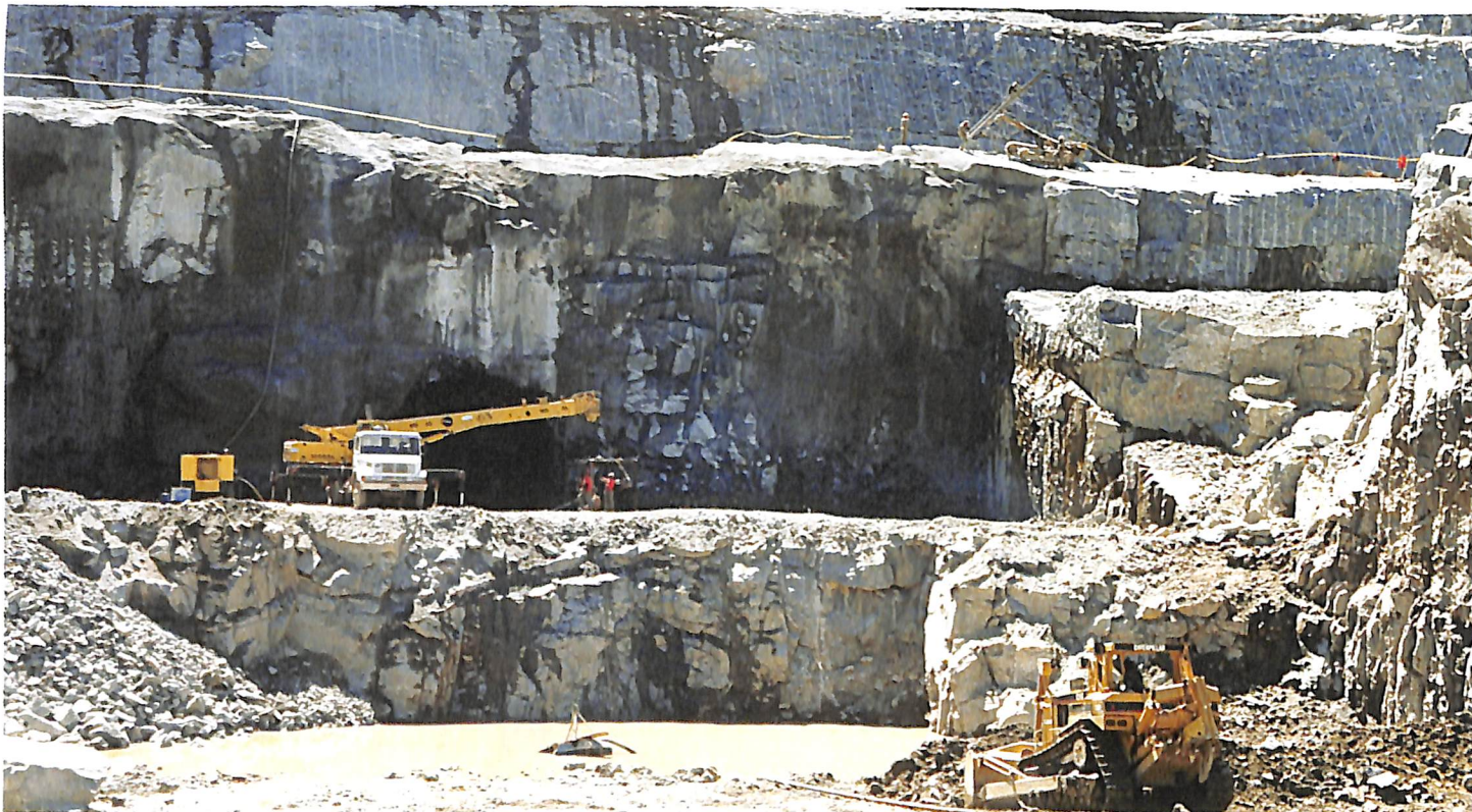
Casa de Força receberá 36.400m 3 de concreto para instalação de três turbinas.
