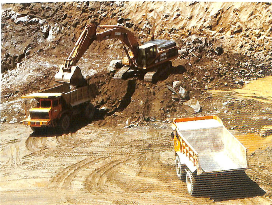
Escavadeira 345B CAT: carga de material e escavação a céu aberto.
