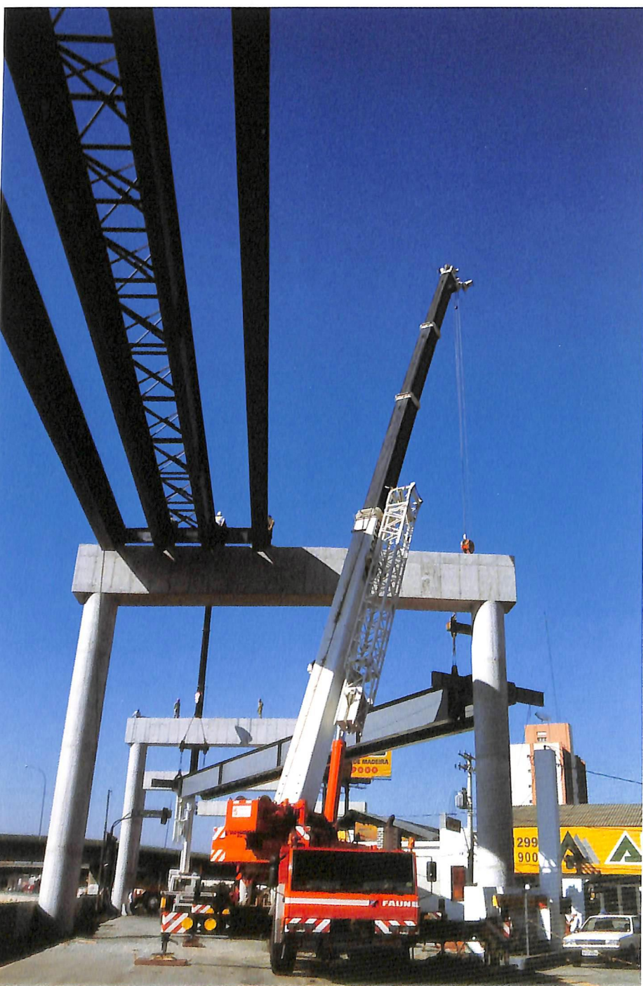
Lançamento de vigas para via elevada.
