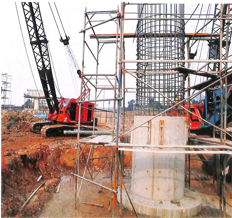
Execução de fundações no Terminal Sacomã.
