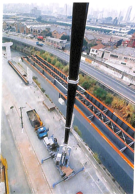
Vigas de 15 a 45 metros entre pilares.
