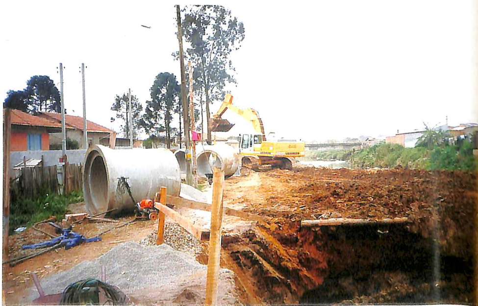
Obras: impacto social e geração de empregos.
