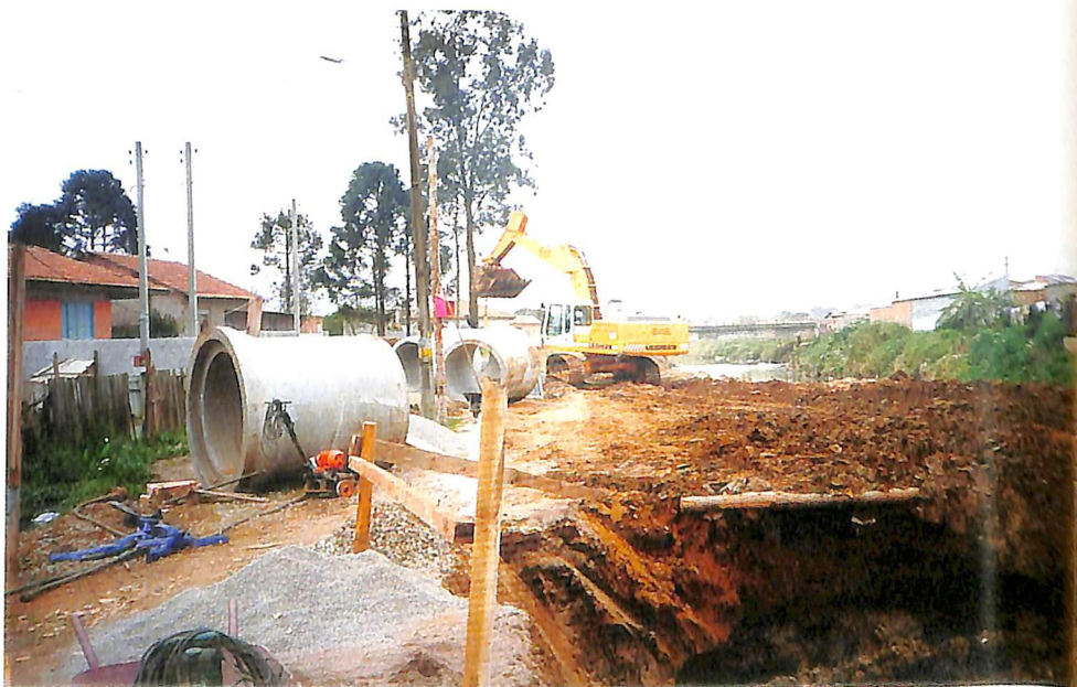
Obras: impacto social e geração de empregos.
