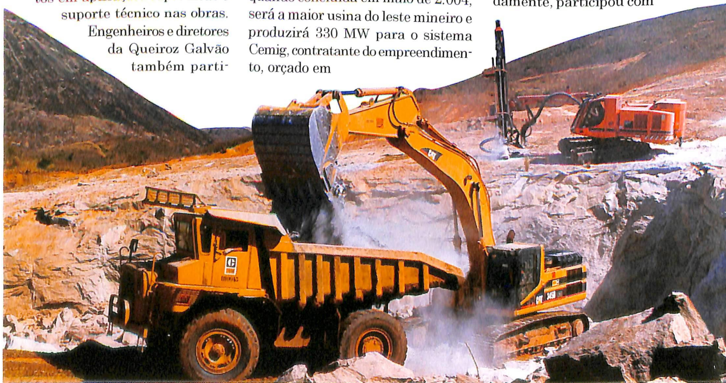
"Escavação em rocha do canal de adução da usina hidrelétrica de Aimorés (MG)".
