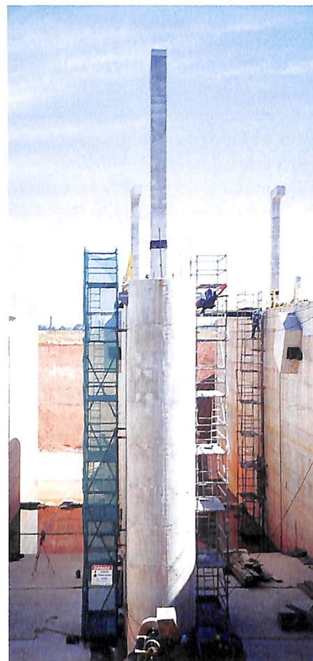
Descarregador de fundo.
