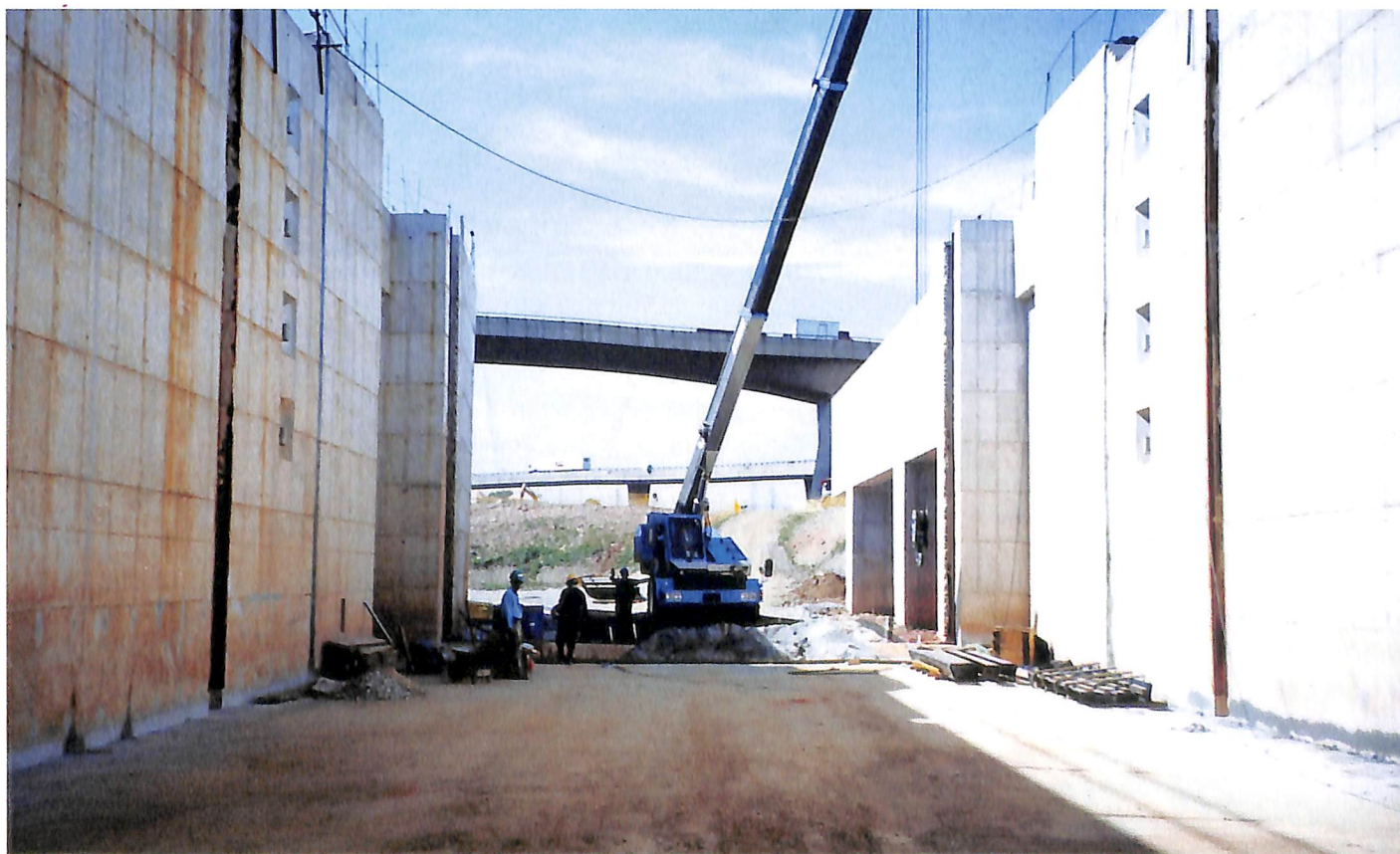
Fase atual é de montagem eletromecânica.
