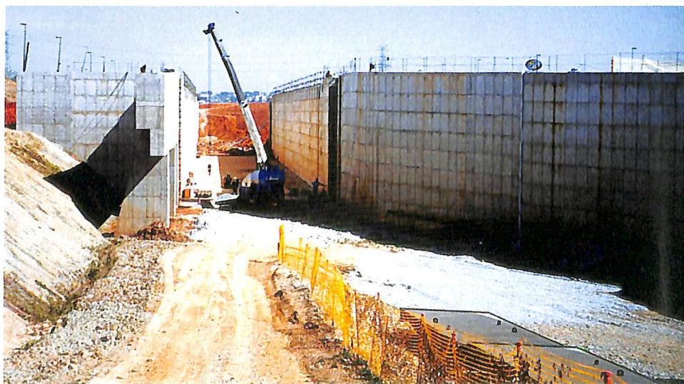
Eclusa: câmara de concreto com 12 m de altura.
