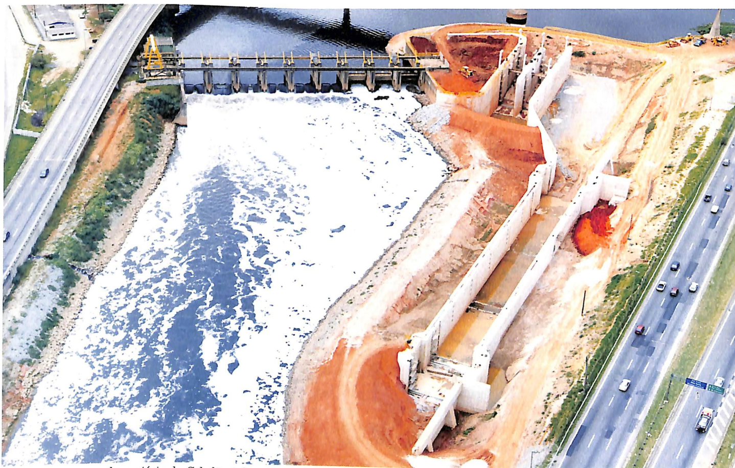
Obra junto ao complexo viário do Cebolão irá permitir a navegação de barcaças no Tietê.
