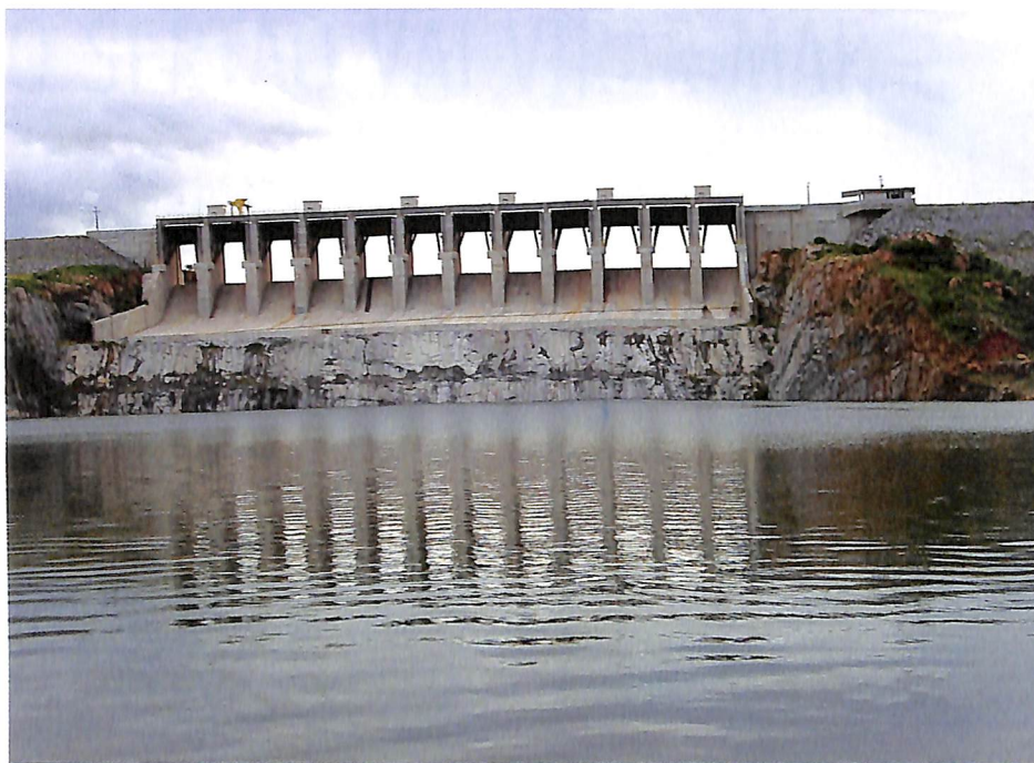
Represamento e contenção de enchentes.
