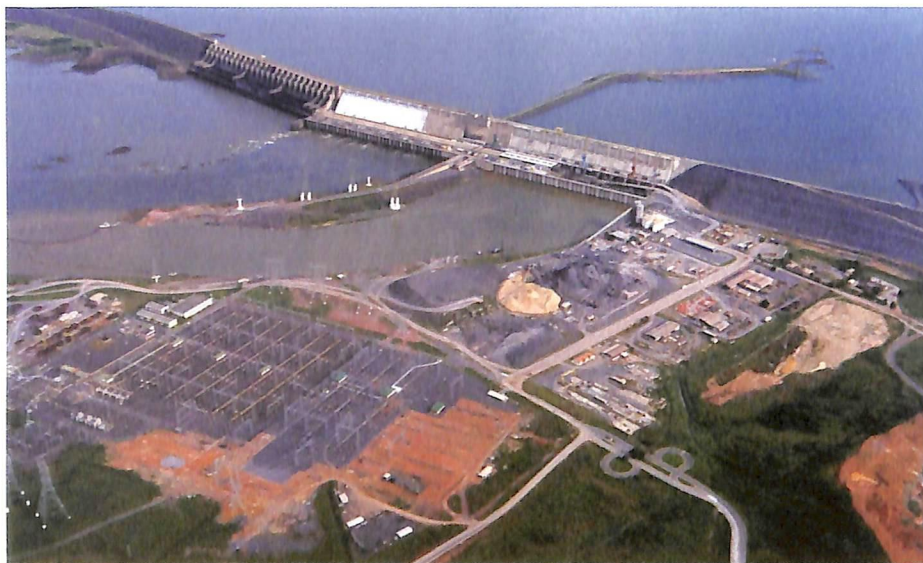
Obras irão duplicar capacidade instalada
