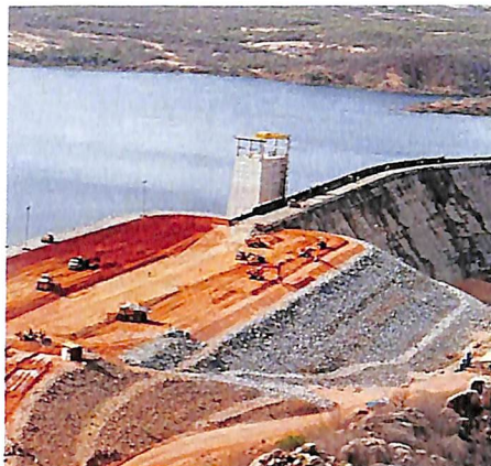
Vista de jusante
