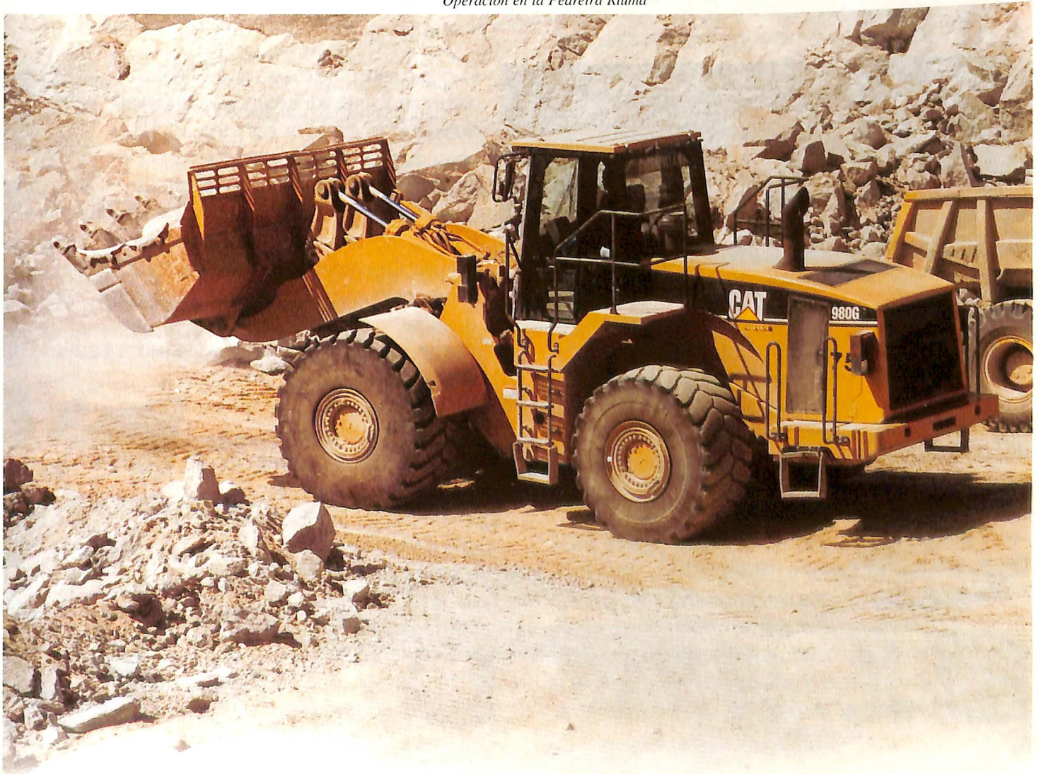
Operación en la Pedreira Riuma
