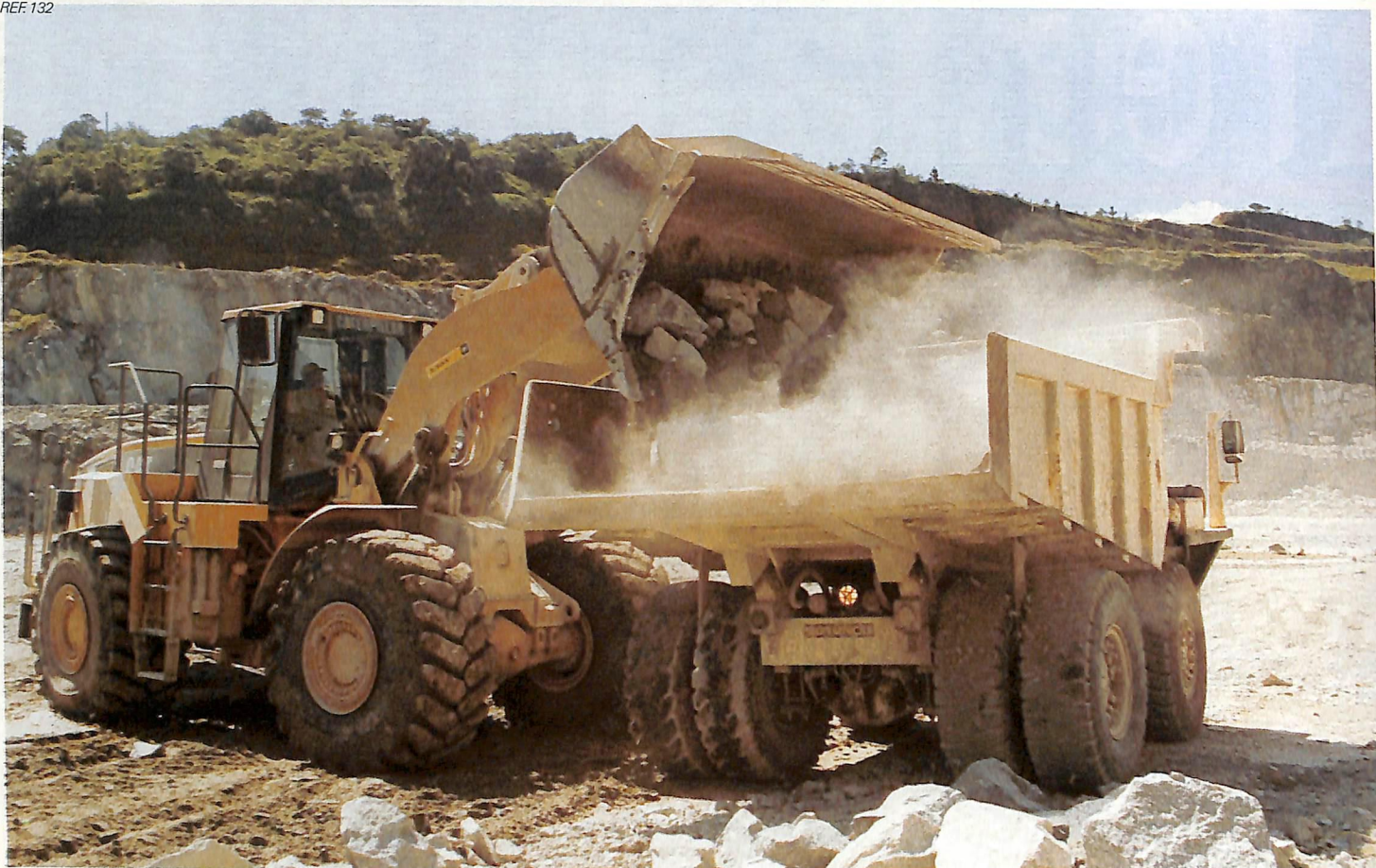
980G em operação na Concrebrás: carregamento de cinco caminhões de 25 t
