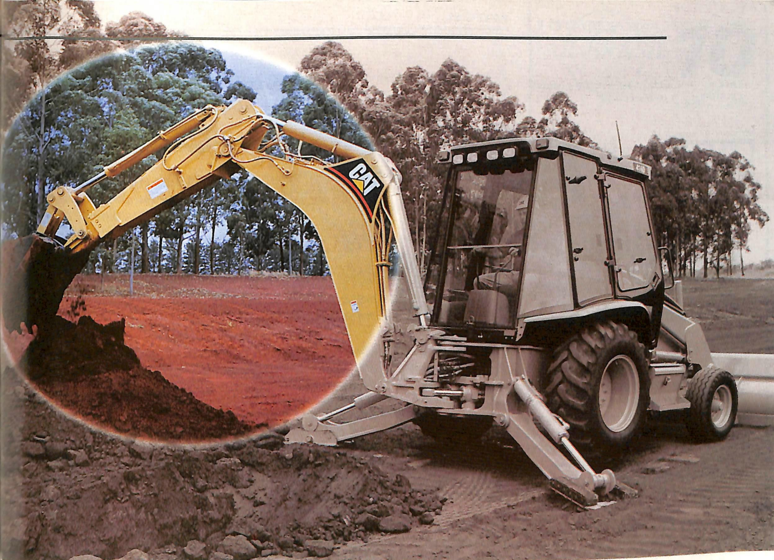
Braço de "escavadeira" e profundidade de até 5,51 m
