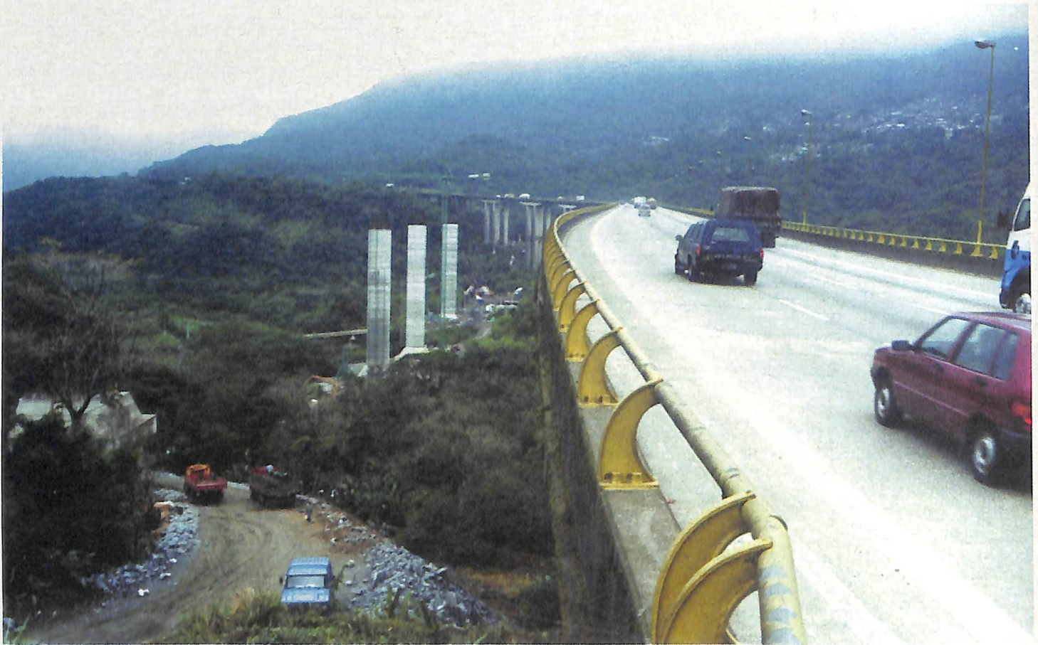
Obra de duplicação da rodovia dos Imigrantes Obra de duplicación de la carretera de los Inmigrantes.
