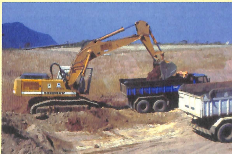
Escavadeiras Liebherr estão abastecendo ininterruptamente uma frota de 95 caminhões Excavadoras Liebherr cargan ininterrumpidamente una flota de 95 camiones.
