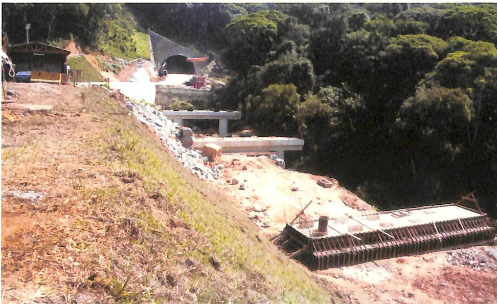
Obra contará com nove viadutos (4,3 Km no total) La obra tendrá nueve viaductos (4.3 Km en total).
