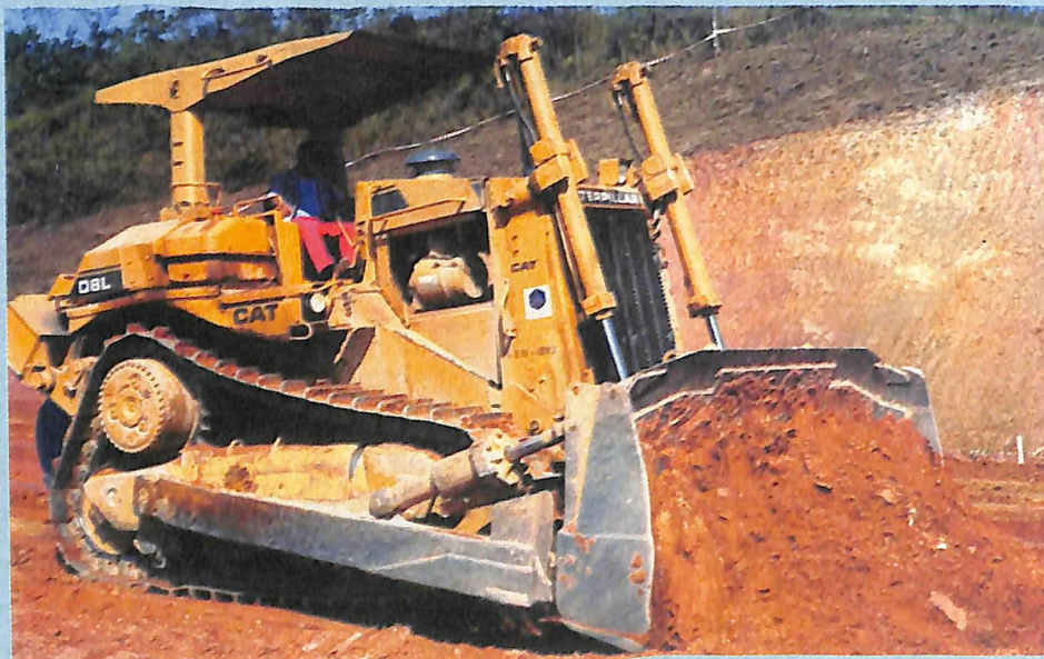
D8: trabalho no "bota-fora" e na terraplanagem do trecho Planalto
