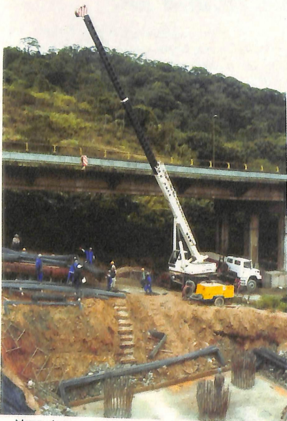
Nova pista consumirá um volume de 380 mil m 3 de concreto e 16 mil t de aço. La nueva calzada consumirá 380.000 m 3 de hormigón y 16.000 t de acero.
