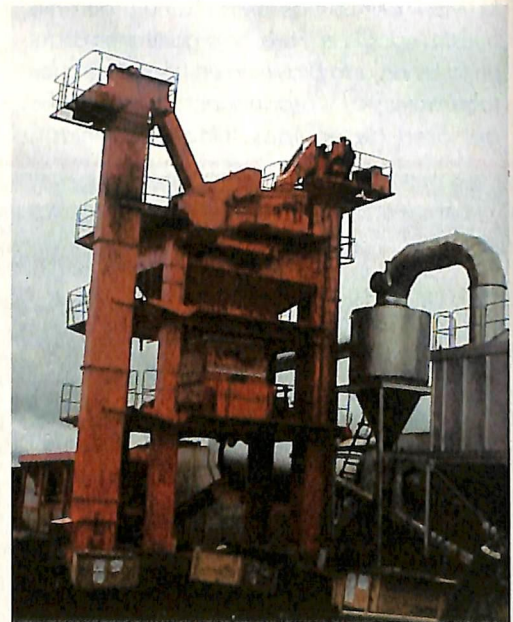
Usina que está sendo montada em Orlândia
