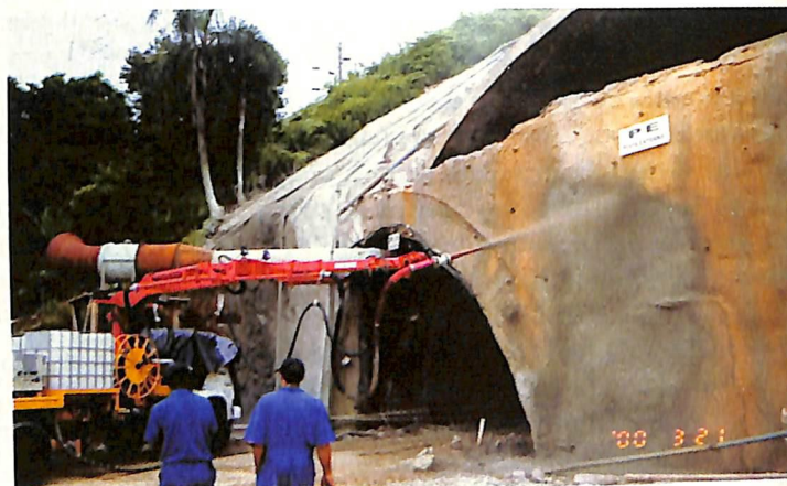
“Robô” Putzmeister Para Concreto Projetado Via Úmida «Robot Putzmeister» Para Hormigón Projectado de Mezcla Húmeda
