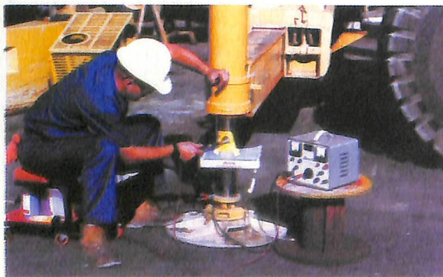
Reparação sem necessidade de desmontagem
