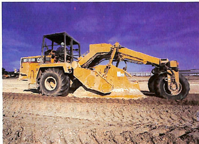
Estabilização de solos
