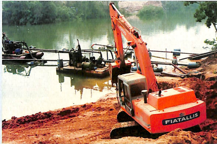
Obras de Manso: manutenção a cargo do distribuidor
