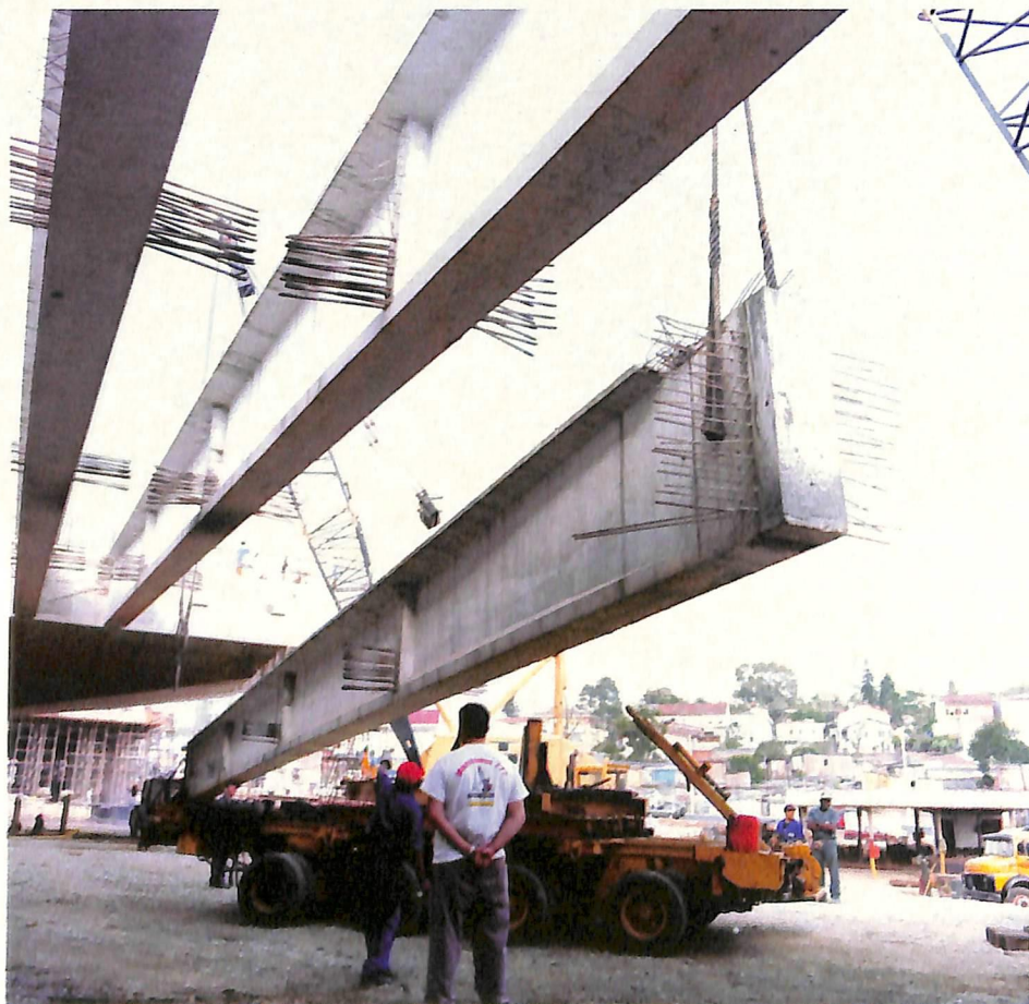
Coreografía de guindastes no lançamento de vigas
