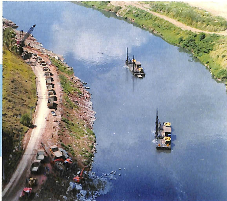
Obras de rebaixamento e ampliação da Calha do Rio Tietê
