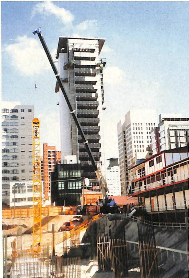
Guindaste sobre o canteiro: símbolo da construção
