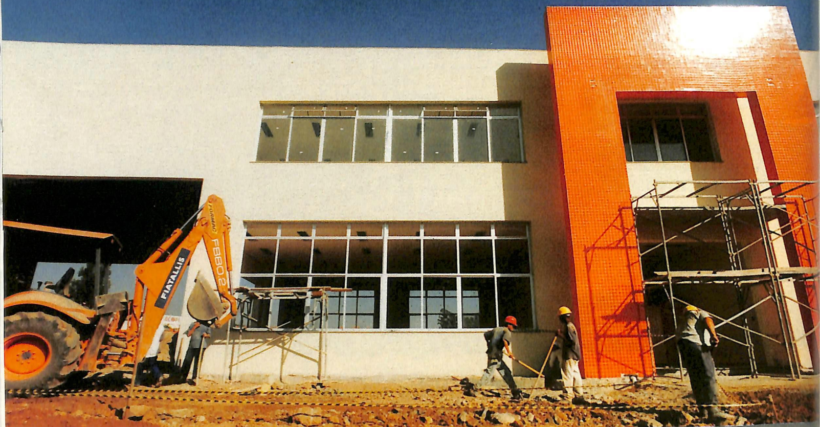
Obras do Centro de Treinamento, recentemente inaugurado
