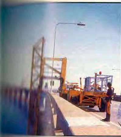
PONTE RIO - NITERÓI
