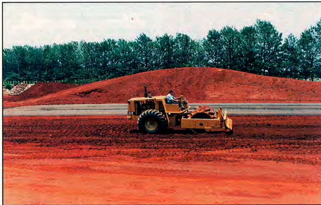
Compactação: objetivo é obter maior densidade com menor número de passadas.
