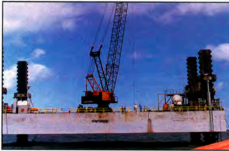
Porto de Pecém: 1.200 estacas com precisão de 80 mm
