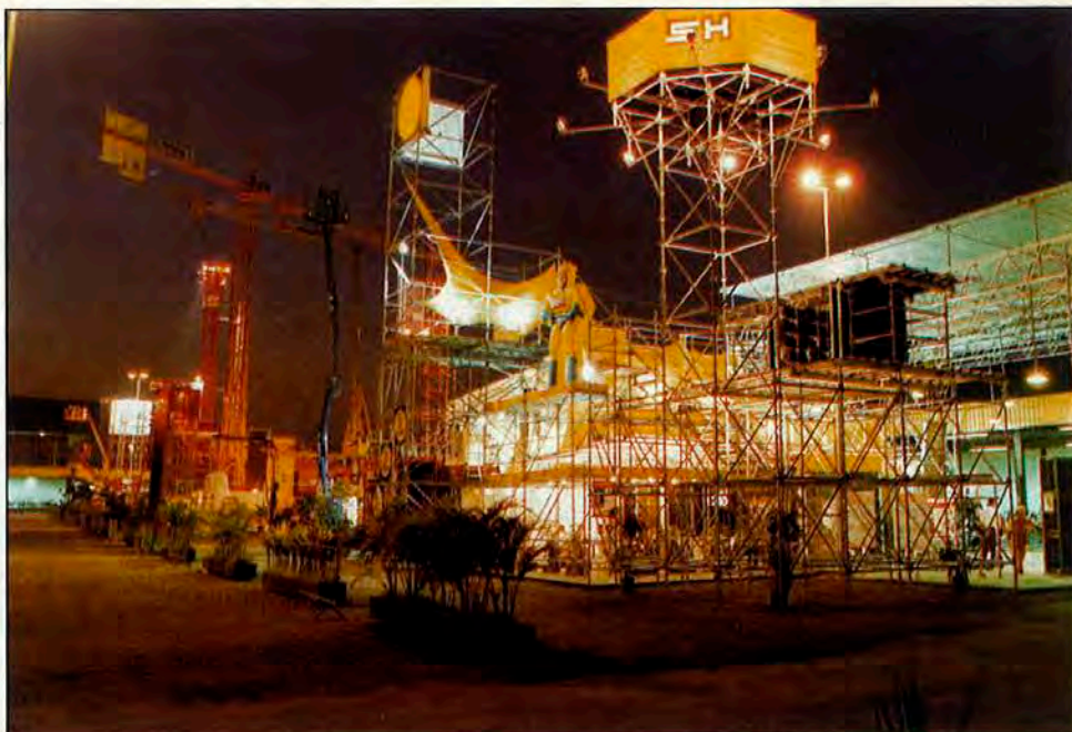
Maior capacidades nas torres de carga e andaimes
