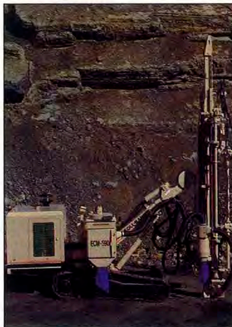
Carretas de perfuração hidráulica
