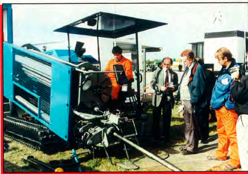
Instalação de tubos: técnica não destrutiva.
