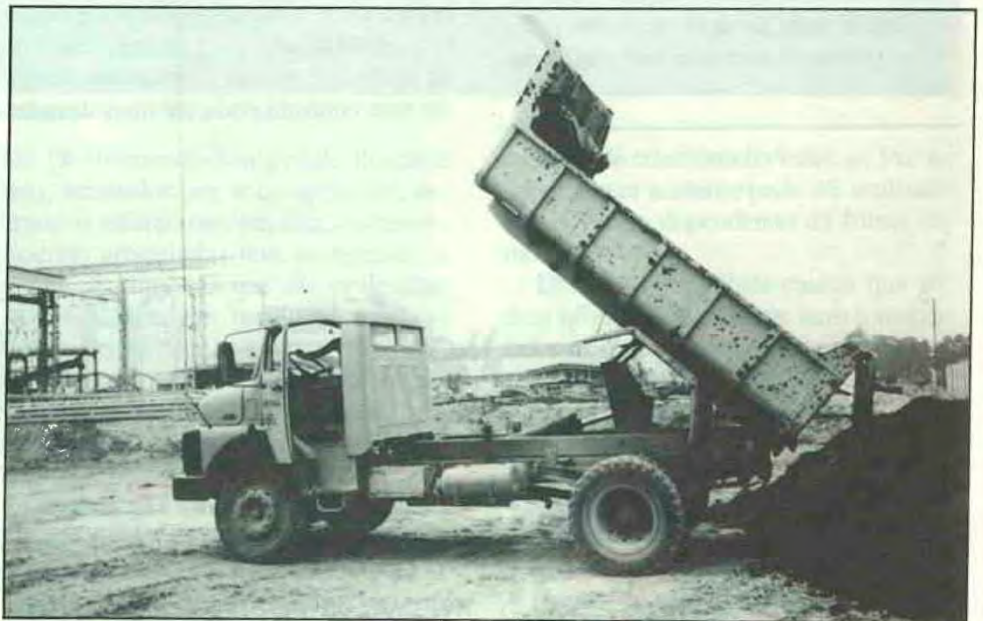
Término de descarga em condições favoráveis de trabalho.
