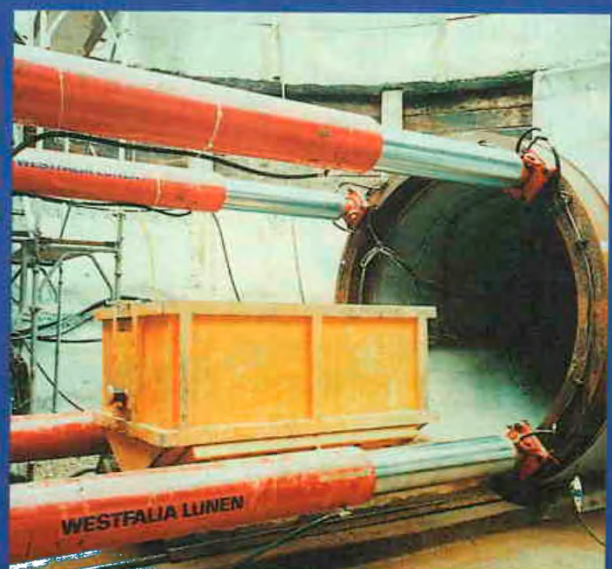
PIPE-JACKINGS DE 0,5 A 5MØ
