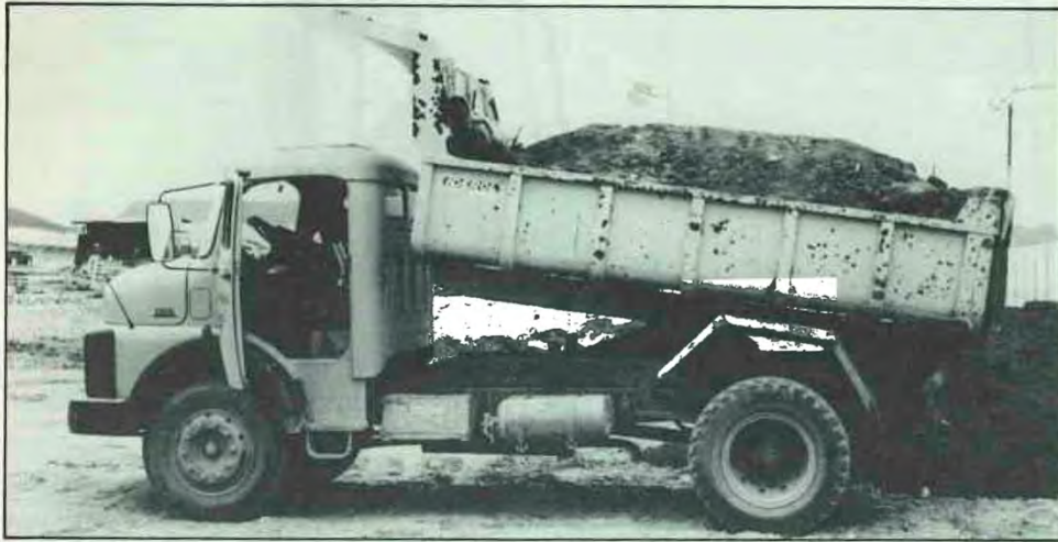
O início de operação de descarga em praça plana e isenta de interferências.
