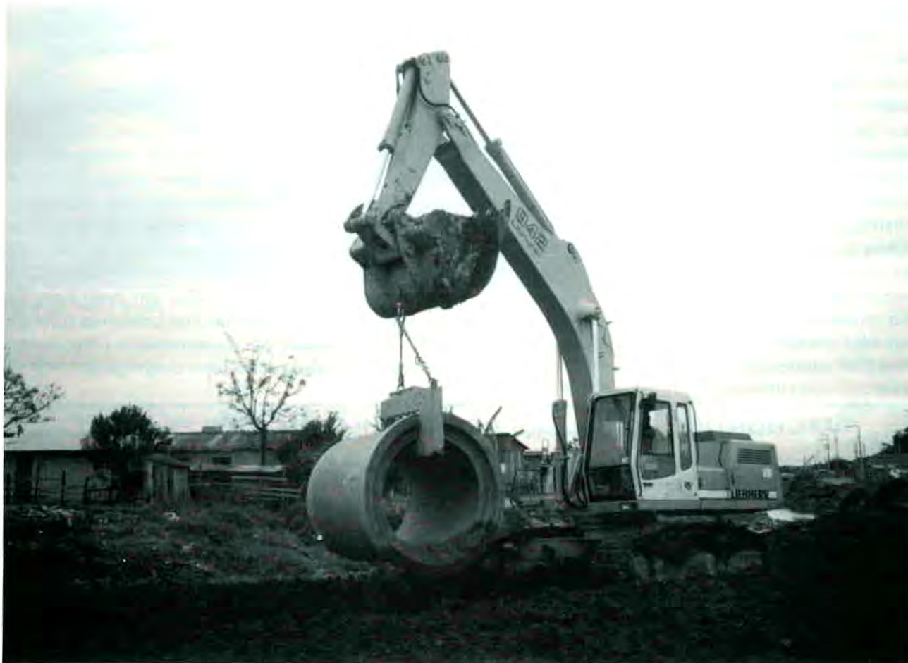
Escavadeira Liebherr R942 HD-SL Litronic em ação
