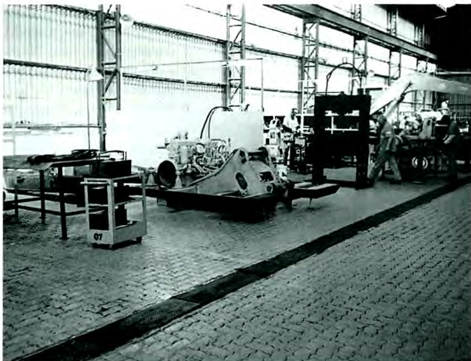
Detalhe do início da montagem de equipamentos após reforma.
