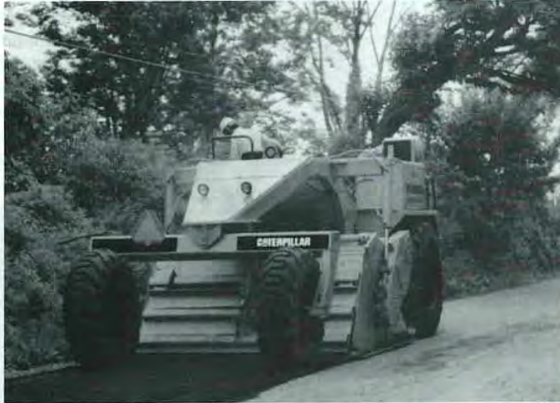
A recuperadora de rodovias melhora a qualidade da base com uma única passada.
