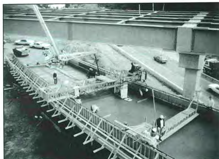
Acabadoras de concreto têm grande aplicação em túneis e viadutos, onde é imprescindível a colocação de pavimento rígido.
