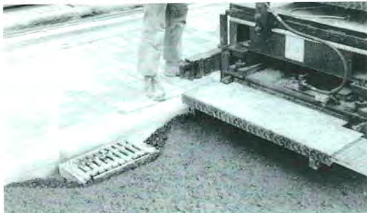
A mesa extensível da pavimentadora permite fazer o contorno de bocas-de-lobo
