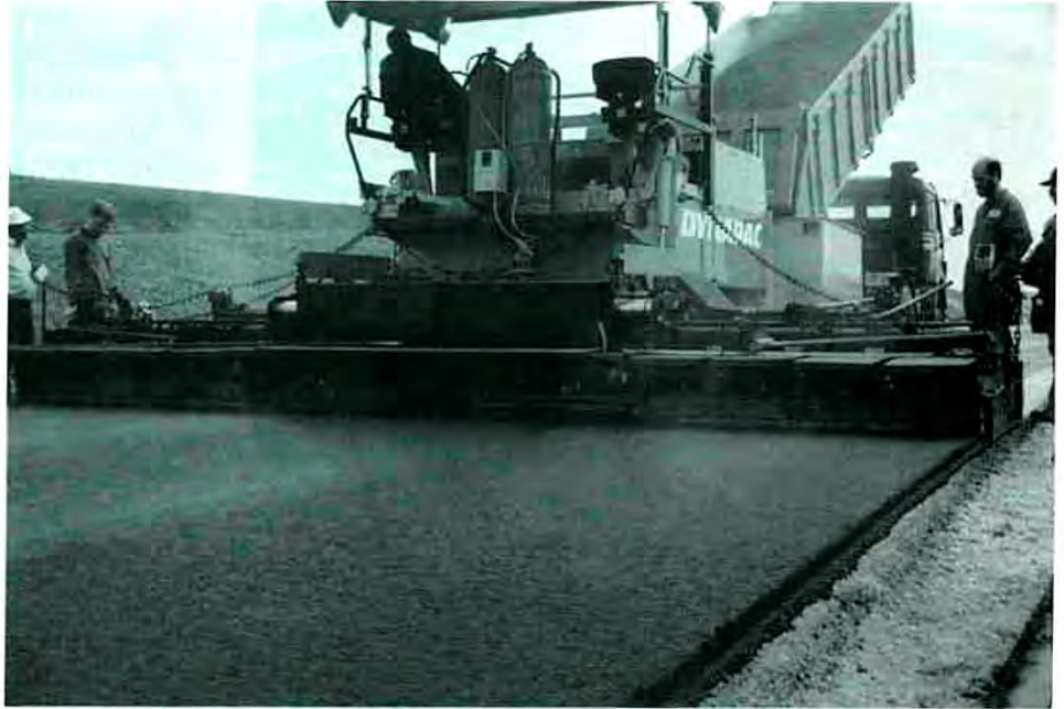
Pavimentadoras de grande porte operam faixas de até 15,0 m de largura.
