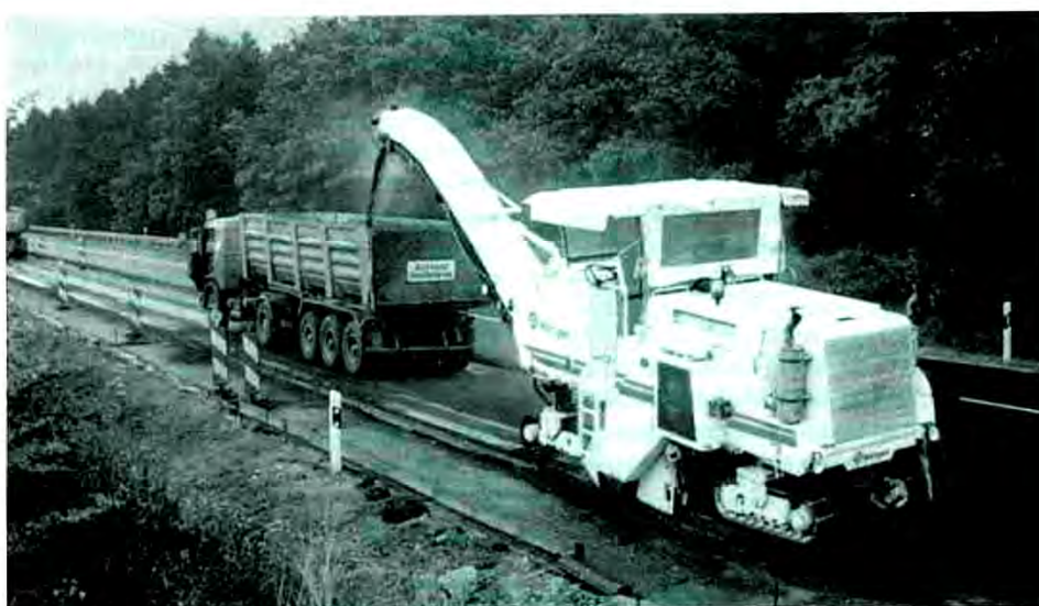
As fresadoras podem restaurar só a capa asfáltica ou também trabalhar a base do pavimento.
