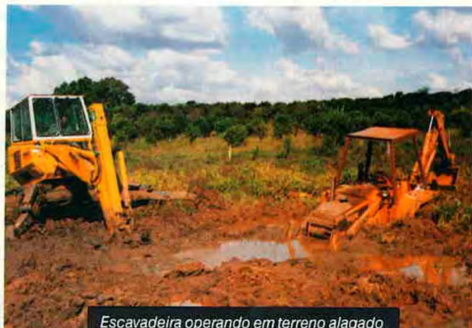
Escavadeira operando em terreno alagado
