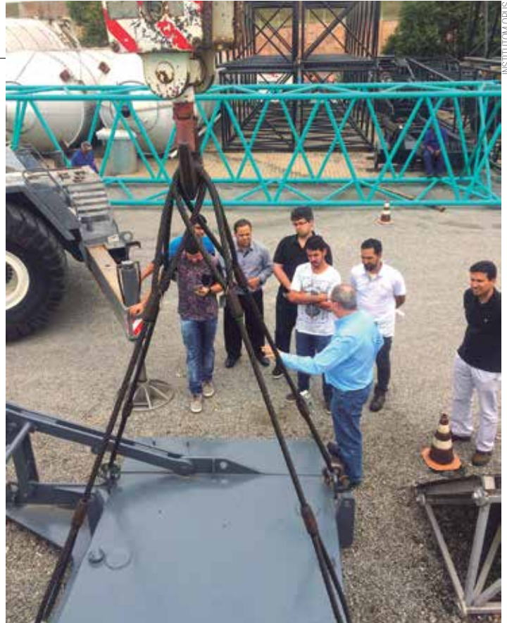
Em movimentação de carga , a falta de capacitação acarreta aumento de acidentes
