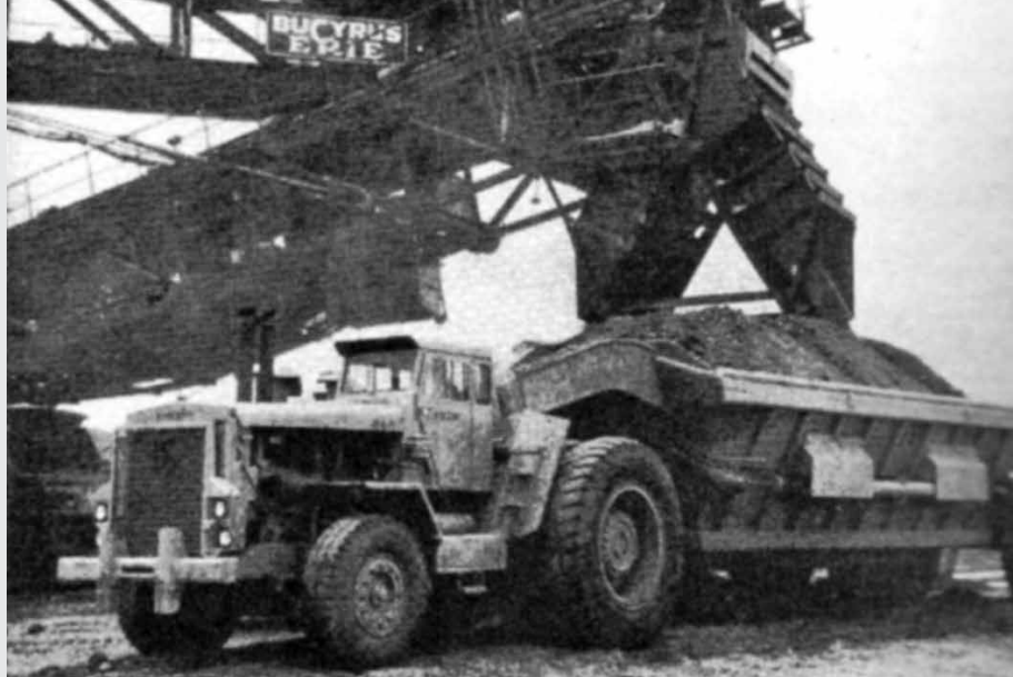
Com 91 ton de capacidade , o basculante Euclid B-100 tinha quase 20 m de comprimento e sua velocidade máxima chegava de 68 km/h
