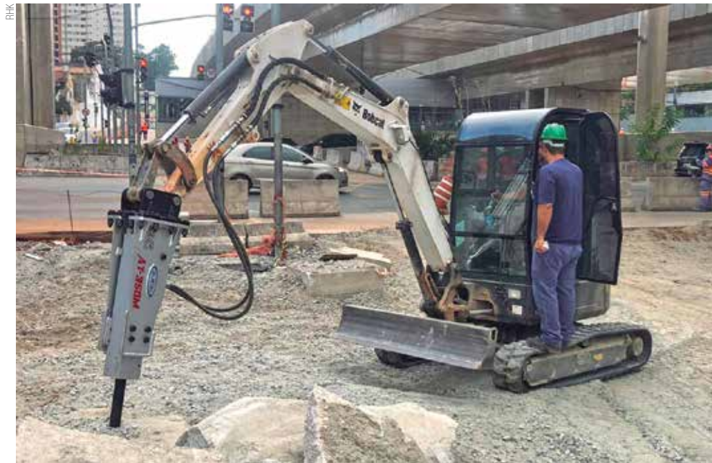
Parâmetros de vazão e pressão garantem que a máquina transfira a energia necessária à operação
