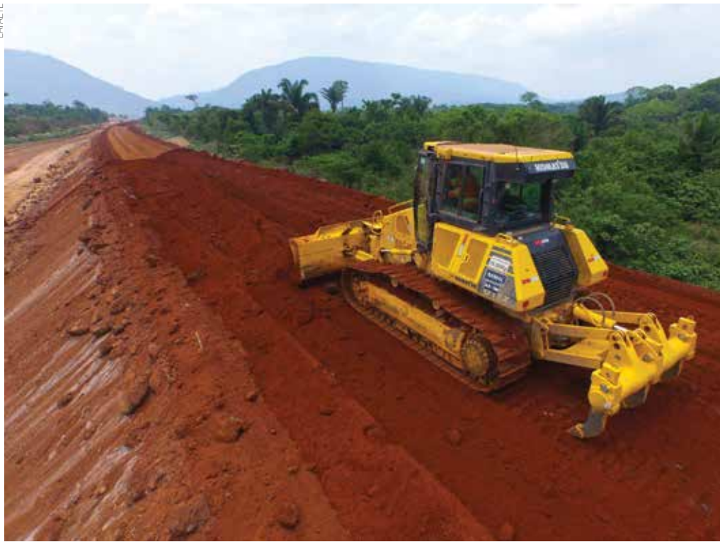
Material escavado pode ser removido ou utilizado dentro do próprio canteiro
