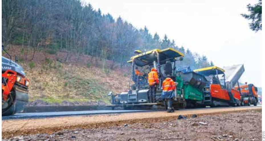
Conjunto de equipamentos depende da velocidade de avanço da obra, mantendo constante o fluxo
