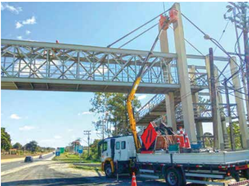
Em meio à pandemia, CCR promove serviços de recuperação em estruturas
