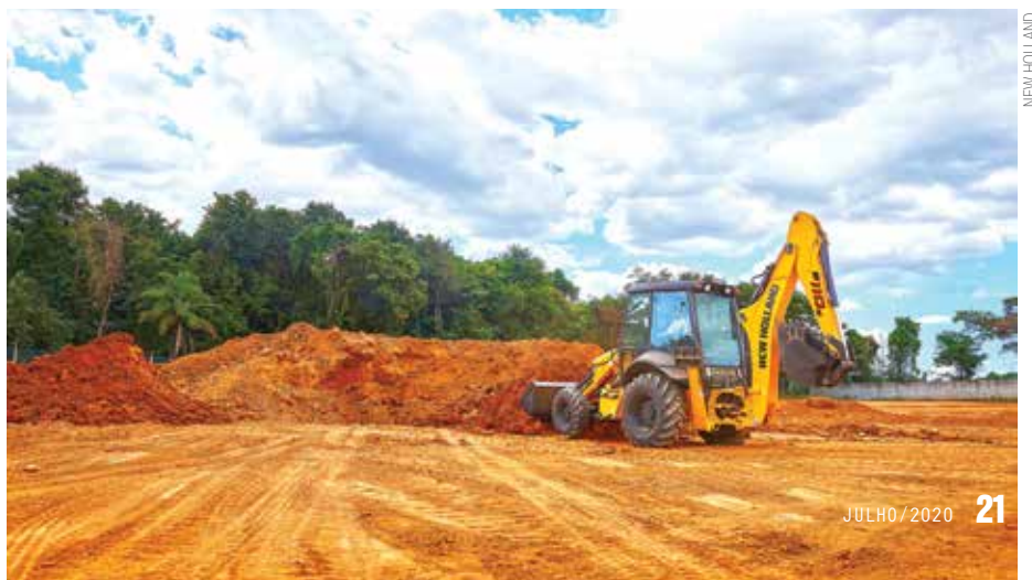
Retroescavadeiras não ficam à margem dos avanços tecnológicos da Linha Amarela
