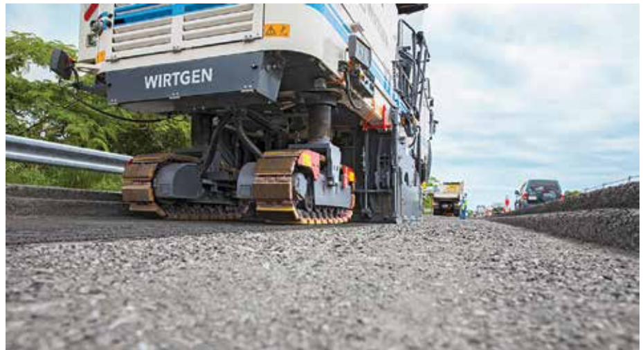
Com controle da água, fresagem inteligente permite otimizar o reaproveitamento do granulado
