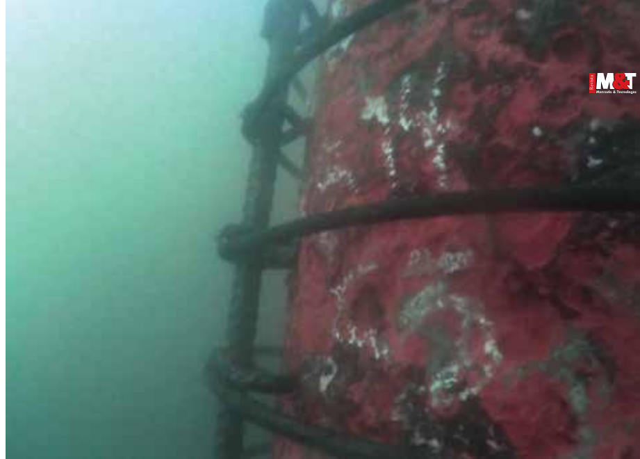
Sob correnteza intensa , obras na parte submersa exigiram perícia das equipes
