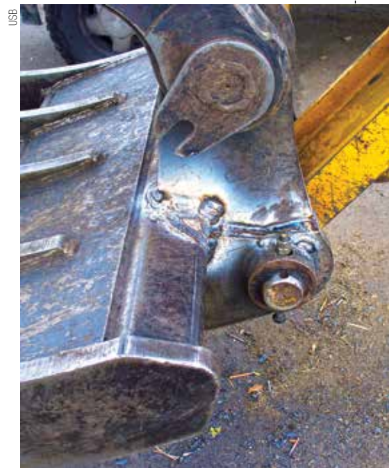
Remendos exigem atenção a detalhes estruturais
