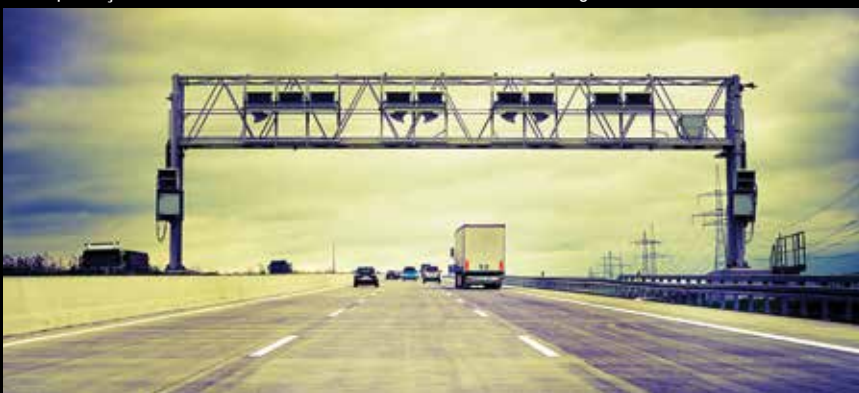
▼ Implantação de sistemas “free flow” vem sendo discutida na modelagem das concessões
