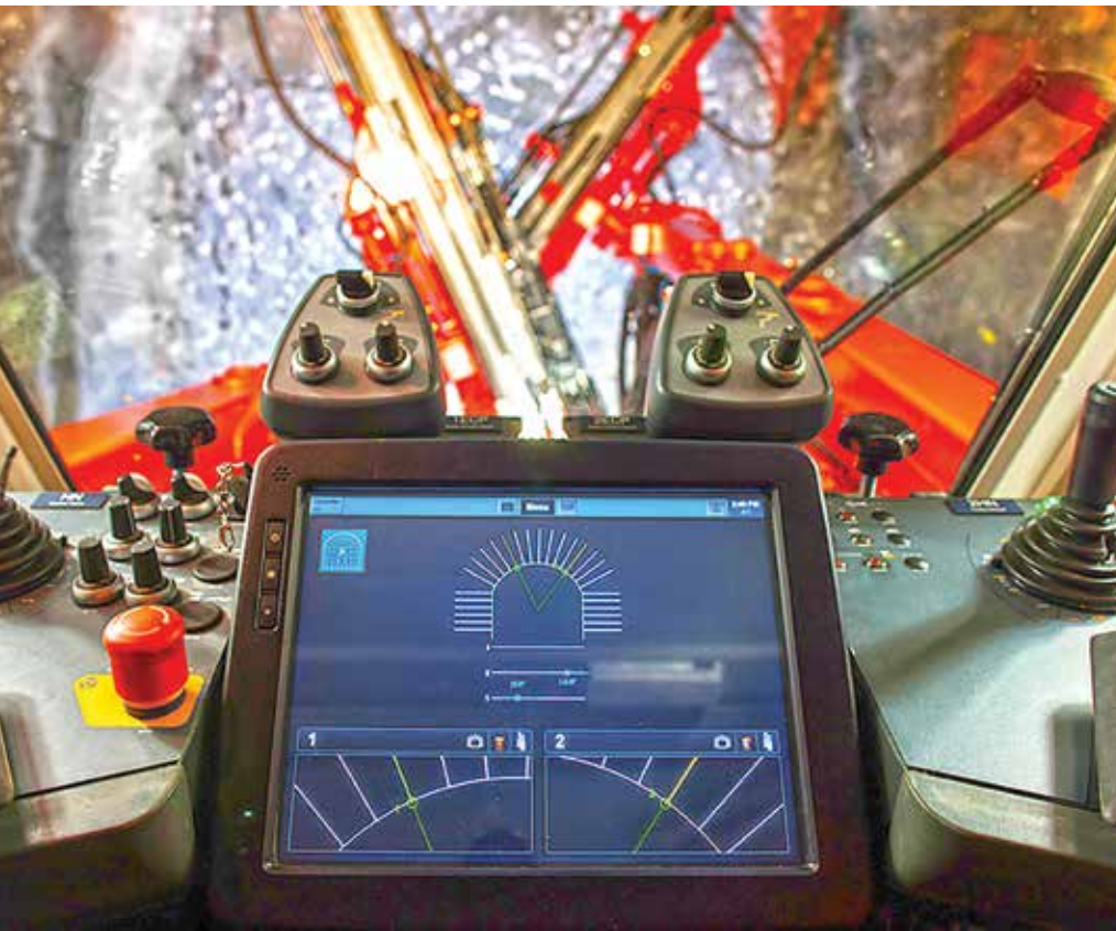
Sistemas de instrumentação garantem maior precisão e paralelismo dos furos na abertura de túneis
