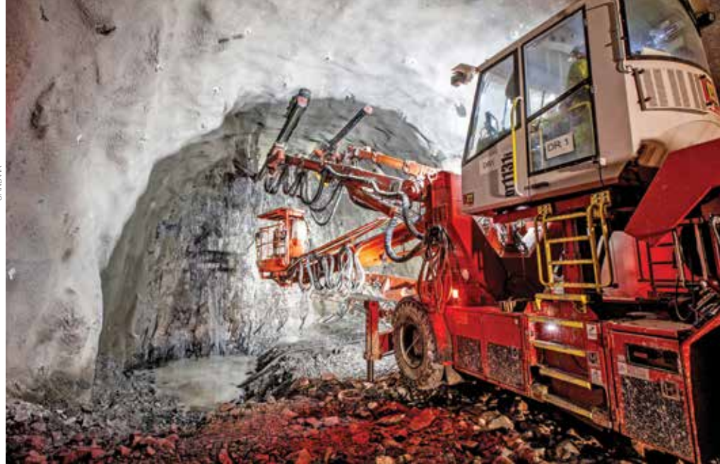
Suporte do material a ser escavado é de vital importância para a segurança na abertura de túneis
