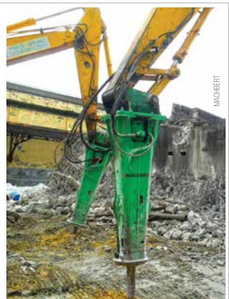
Adaptação de implementos tornou-se mais fácil com os comandos eletro-hidráulicos
