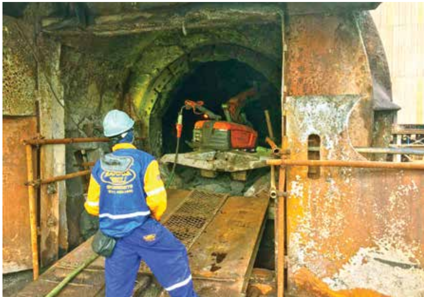
Equipados com implementos, robe retiram o operador da área de ação
