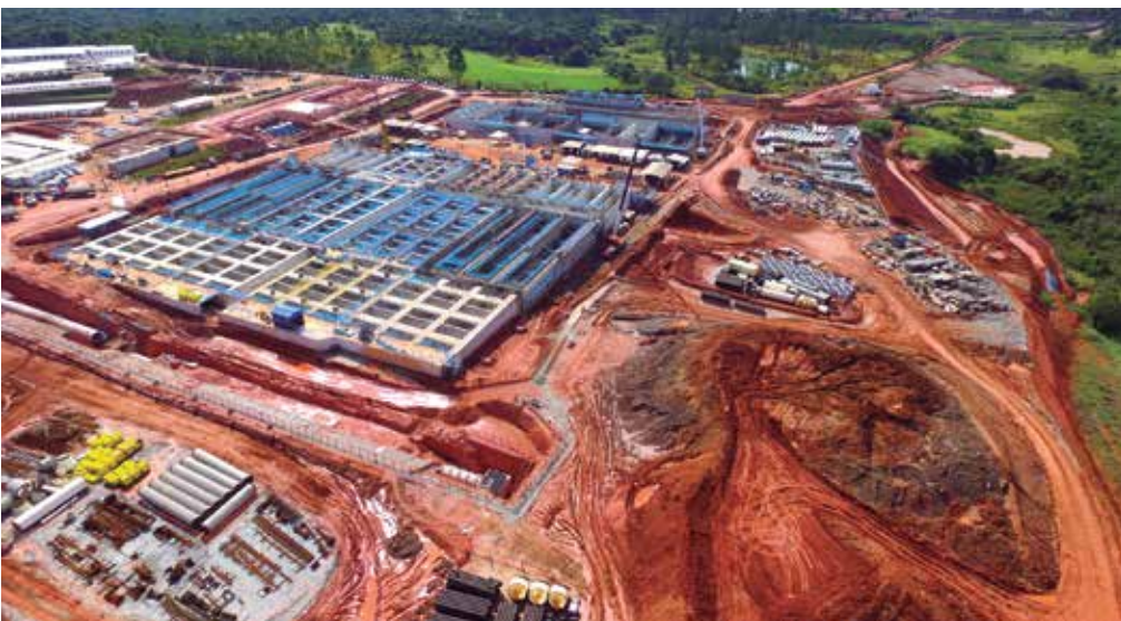
Passando pela Serra de Paranapiacaba, o Projeto São Lourenço inclui 83 km de adutoras e elevação de 330 m
