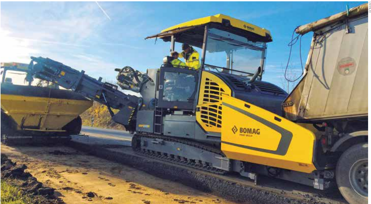
Controle de nivelamento é indispensável para manter a regularidade do pavimento
