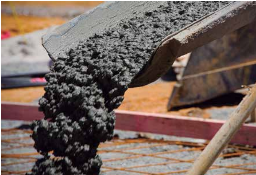
Segundo especialista, fornecimento de concreto configura um serviço de concretagem
