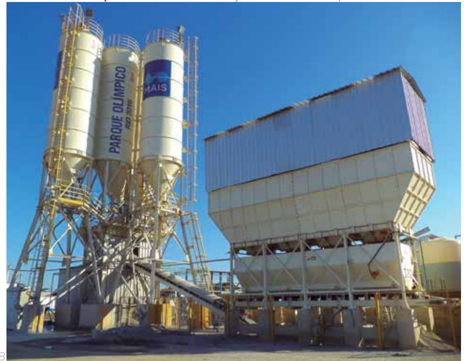
A escolha da matéria-prima e o desenvolvimento do traço incidem diretamente na qualidade do concreto
