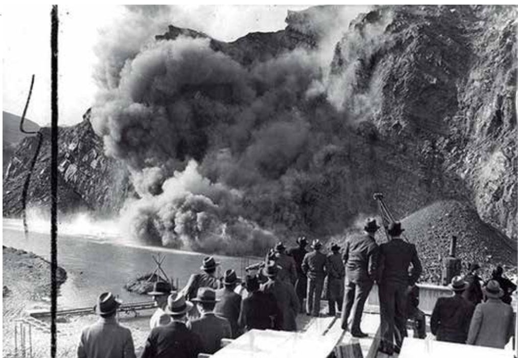
Cena de desmonte de rocha com o uso de explosivos, no início do século XX
