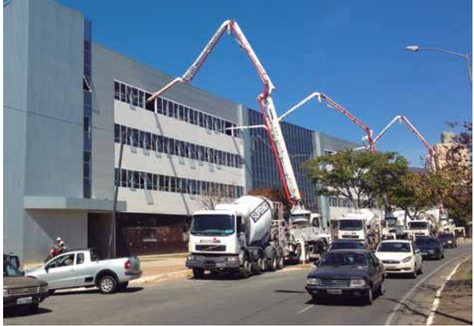
Aproximadamente de 25% a 30% das bombas utilizadas no país pertencem a empresas terceirizadas, dedicadas exclusivamente ao bombeamento de concreto
