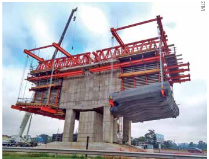
Carro hidráulico de balanço sucessivo está sendo utilizado na Linha 13 do metrô de SP
