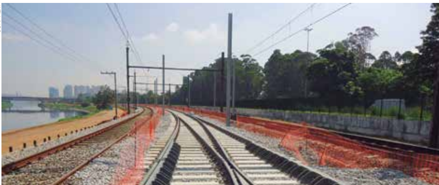
Com vantagens em capacidade e ambientalmente corretos, dormentes de concreto avançam no país
