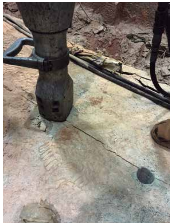
Cunha hidráulica aplica força considerável em um espaço extremamente restrito
