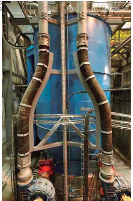
Acoplamento por flanges ou conexões preserva a integridade e permite reutilização
