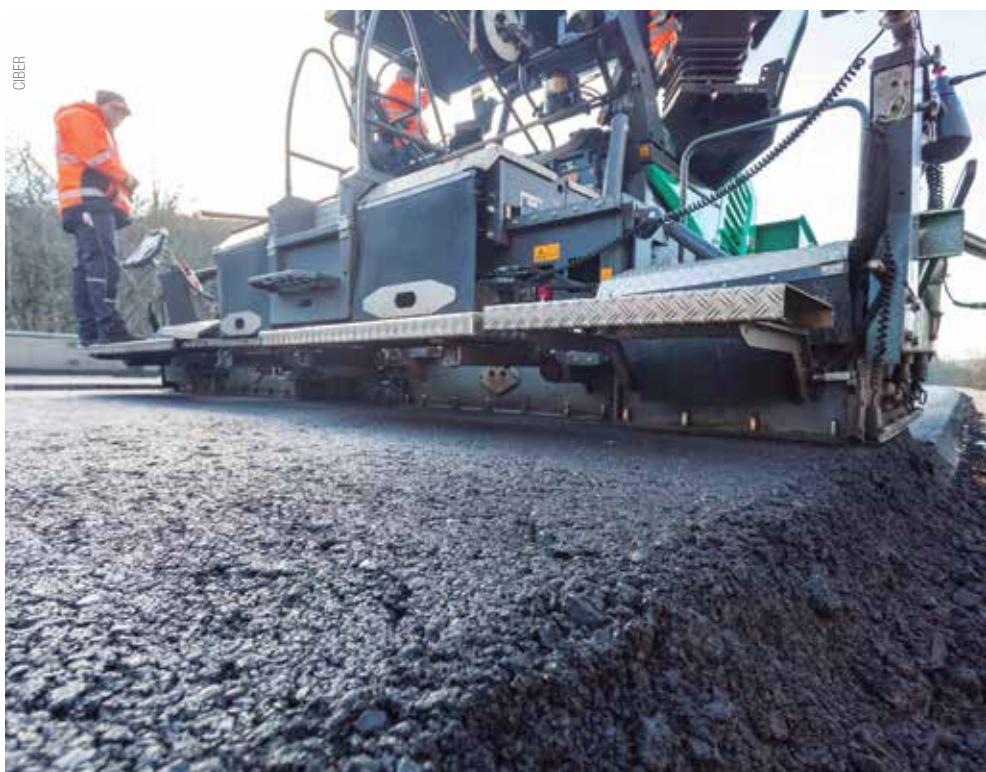
Abertura com controle hidráulico elevou as vibroacabadoras a um novo nível tecnológico
