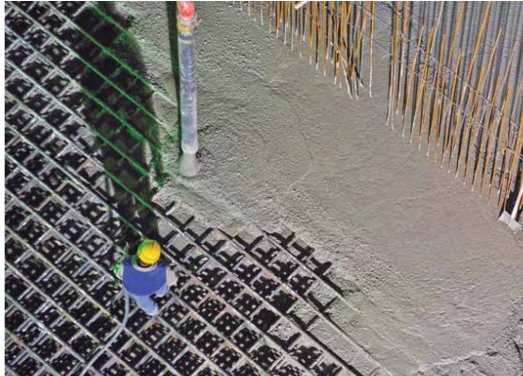
Bombeamento de concreto beneficia-se do uso de produtos químicos, ressalta o executivo
