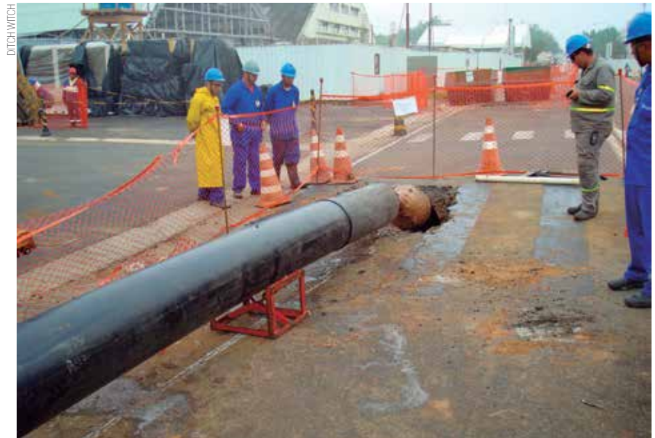
Diâmetros mais usuais de perfurações variam entre 63 e 160 mm em zonas urbanas
