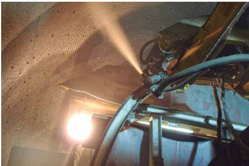
Aditivos e injeções de microcimento garantem a proteção do túnel de Saint-Gotthard
