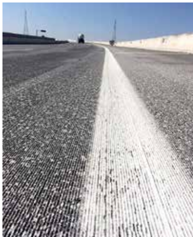
Técnica proporciona macrotextura artificial
