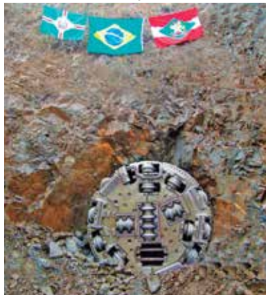
PCH em Santa Catarina utiliza tecnologia para escavar túnel de adução em rocha
