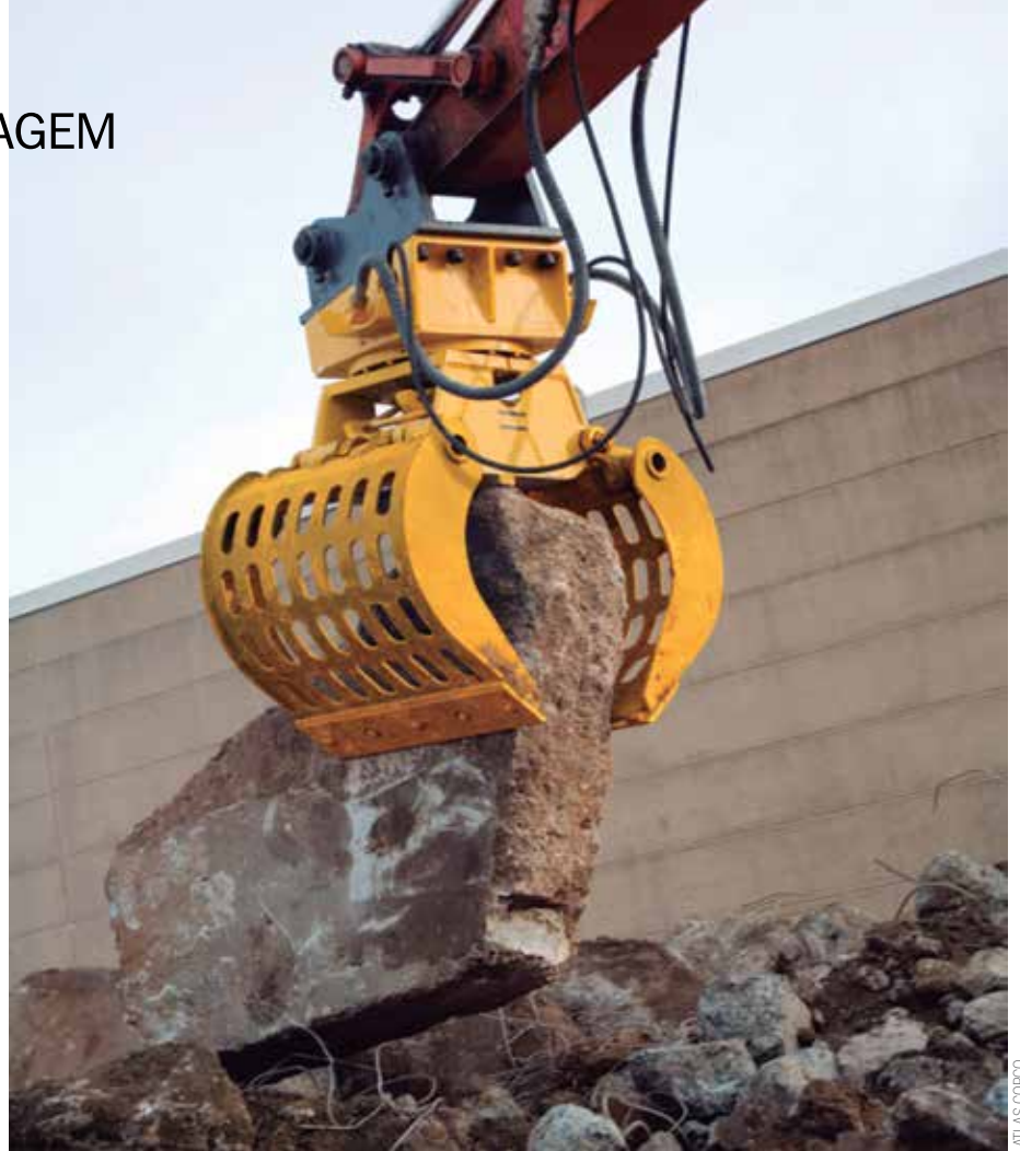
Soluções mecanizadas substituem o uso de explosivos em demolições urbanas
