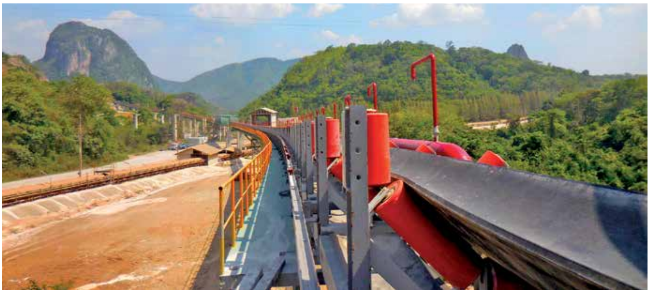
A Beumer projeta sistemas como esta correia transportadora de 3,5 km na Tailândia, ressalta Echelmeyer
