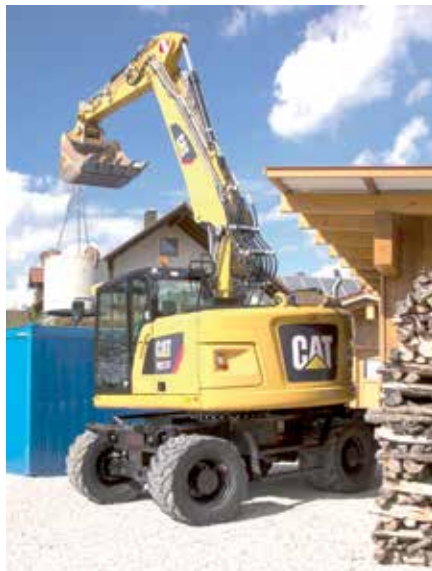
Cat mostra escavadeira sobre rodas M317F com raio de giro reduzido
