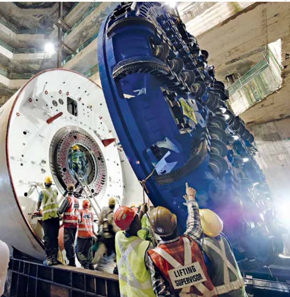
Em TBM's de grande diâmetro, uma equipe técnica faz o monitoramento em tempo real da escavação
