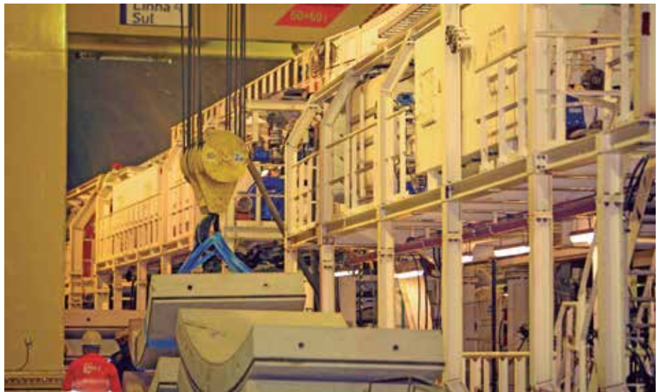
Obra exigiu adaptação da máquina, condicionamento do solo e breakthrough submerso
