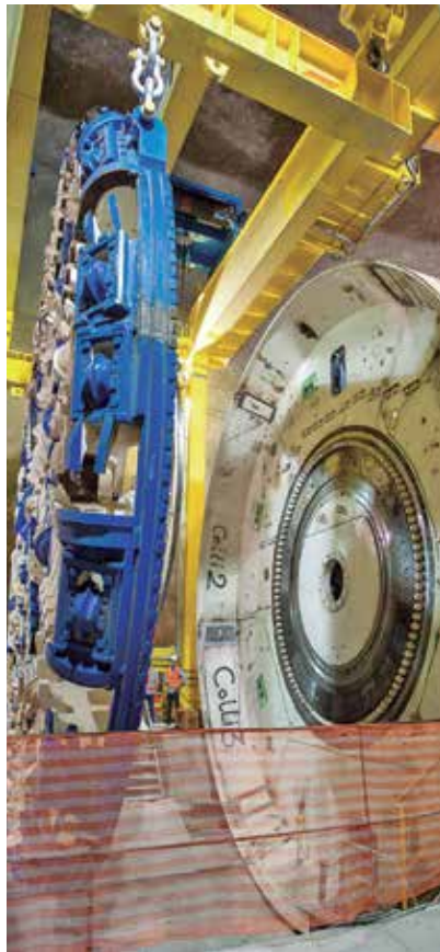
Projeto vencedor realizou paradas preventivas da tuneladora em todas as estações
