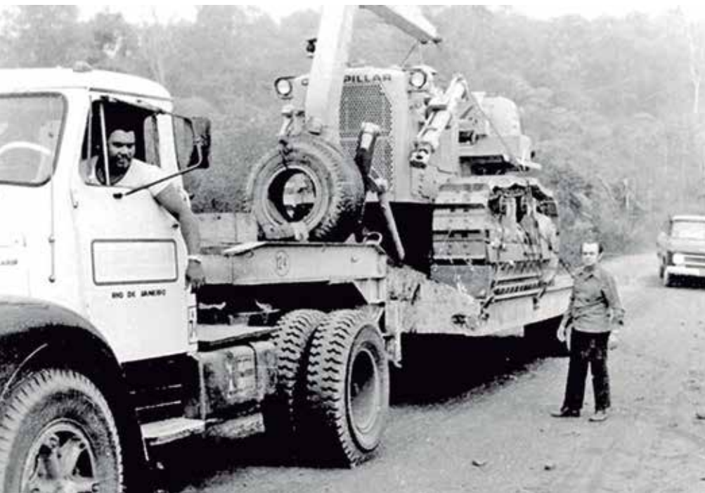
Primeiras máquinas chegaram em 1974 ao futuro canteiro de obras, que mobilizaria 40 mil trabalhadores
