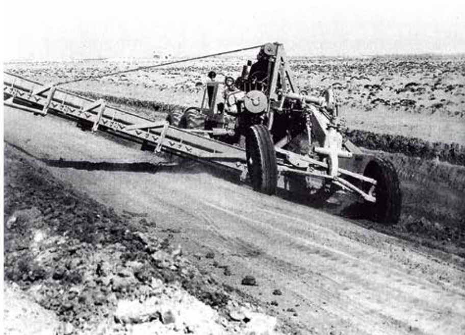
Motoniveladora Caterpillar nº 12 com um Dómor lateral, durante construção de estrada no deserto do Saara em meados dos anos 50
