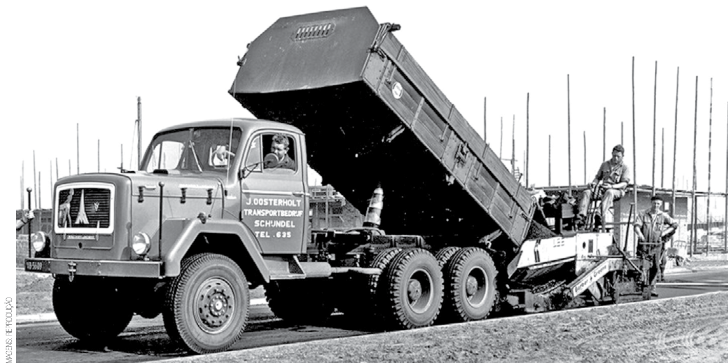
A pavimentadora de asfalto Barber-Greene 879B vista em ação, em meados do século XX
