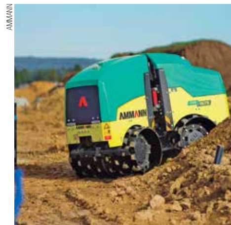
Compactadores de valas são aplicados em diferentes tipos de solos
