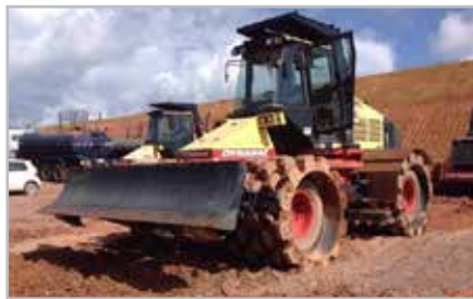
Compactadores de solo
