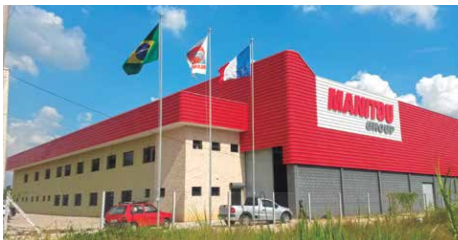
Fachada da fábrica em Vinhedo: aposta na localização
