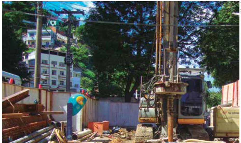
As estacas-raiz podem ser utilizadas em terrenos com perfis geológicos com presença de matacões, rochas e até concreto
