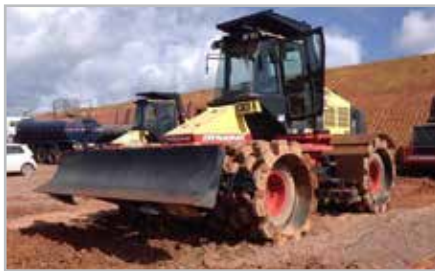
Compactadores de solo
