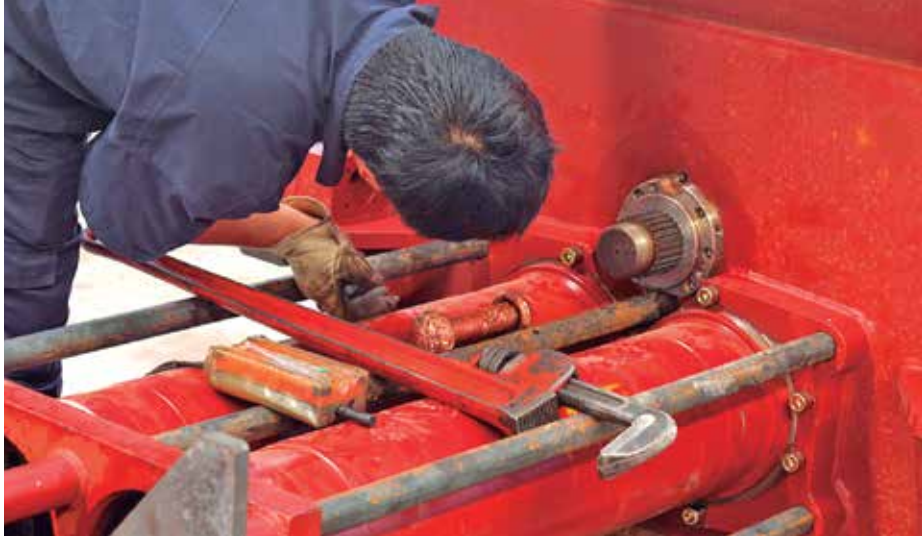
Inspeção de tubulação e componentes permite identificar desgastes e anormalidades
