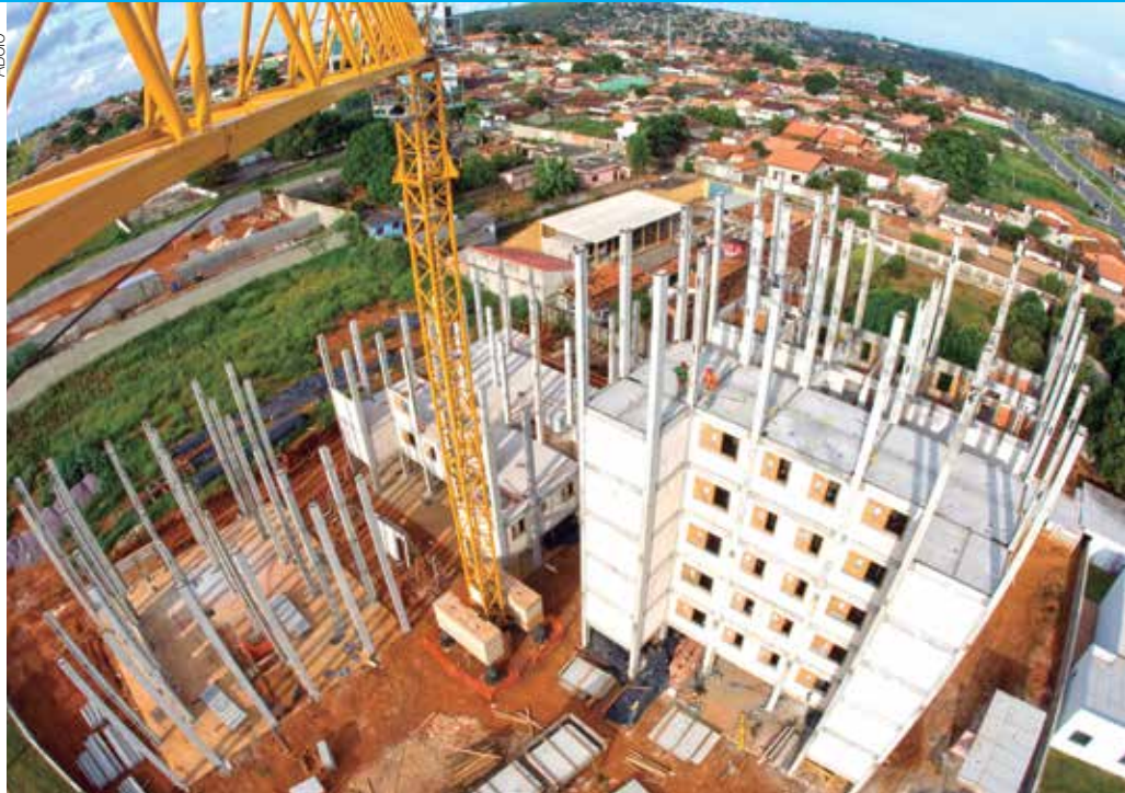
Produtividade exige modernização de processos construtivos e de gestão
