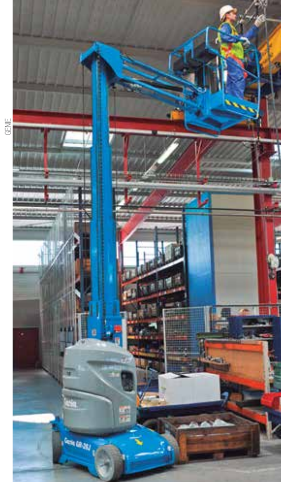
Escolha correta exige conhecimento da altura máxima em que o serviço será realizado
