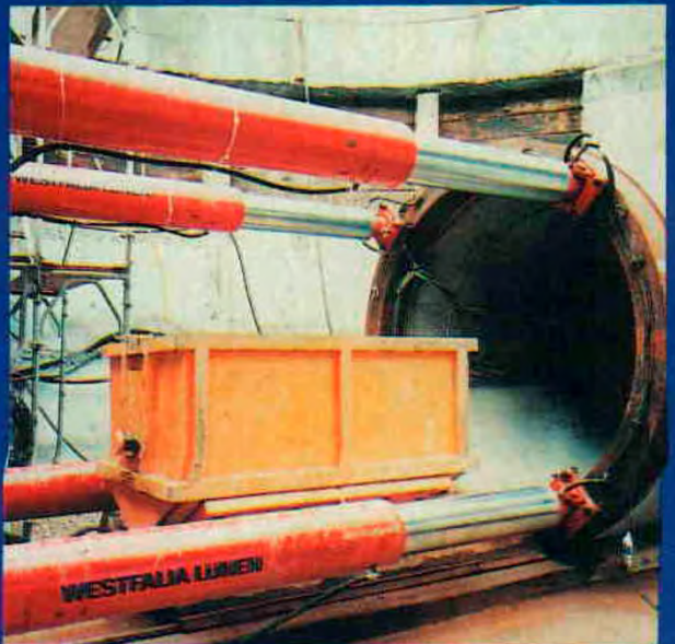
PIPE-JACKINGS DE 0,5 A 5MØ
