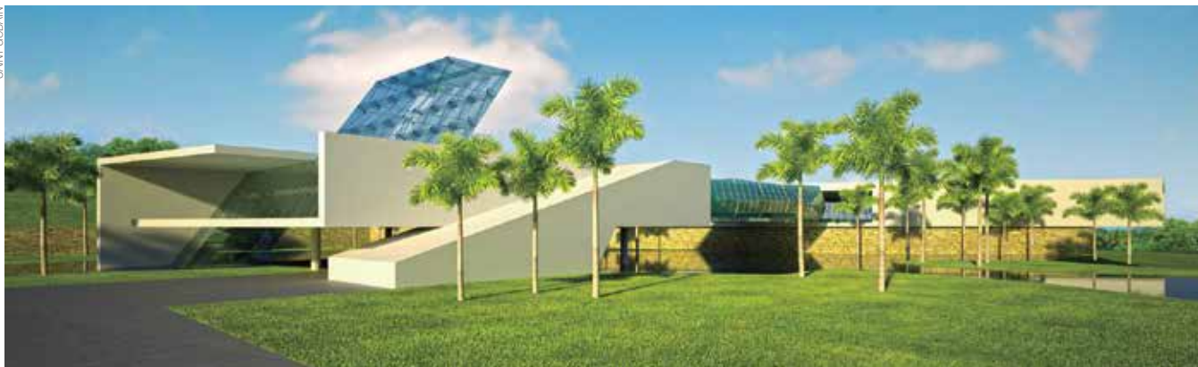
Único no Hemisfério Sul, centro de P&D da Saint-Gobain em Capivari (SP) pesquisa produtos para a construção
