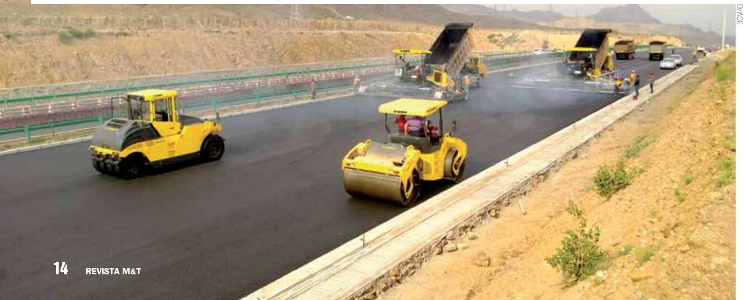
Rolos vibratórios executam a compressão da parte mais grossa da massa, enquanto modelos de pneus fazem o fechamento
