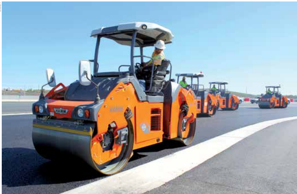
Assim como a quantidade de equipamentos, a sequência de passagem varia de acordo com o construtor
