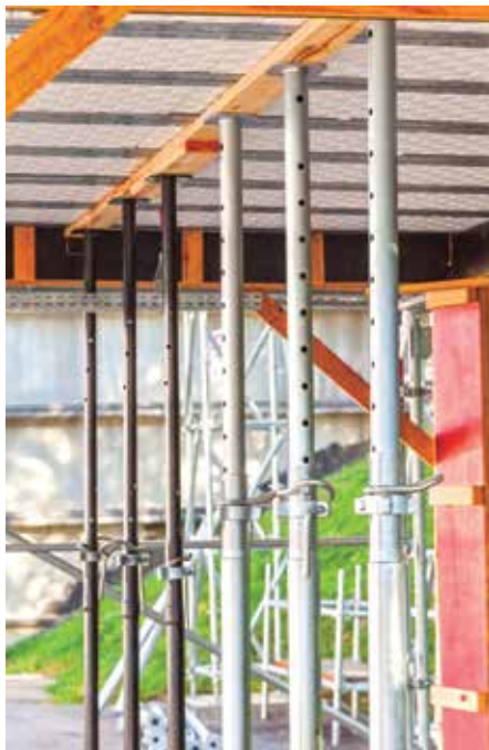
Escoramentos da Tuper são formados por estruturas verticais
